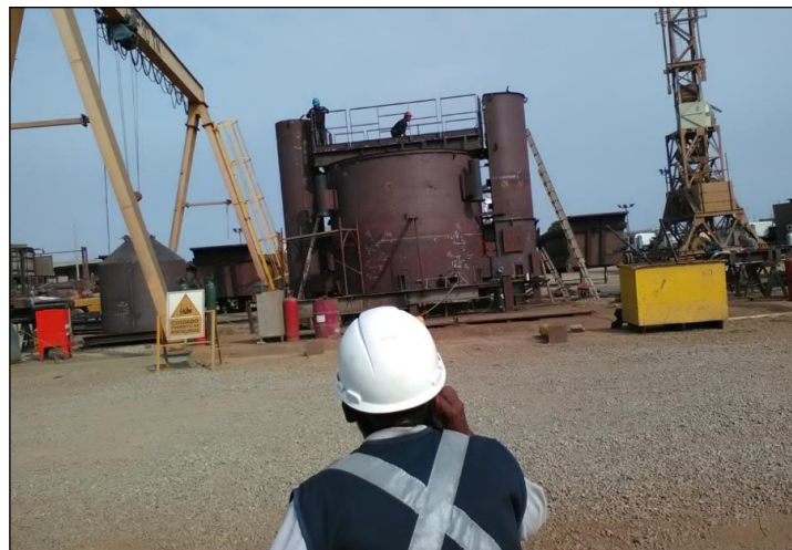
Figura 3.1. Liberación topográfica en planta Cemprotech S.A.C
