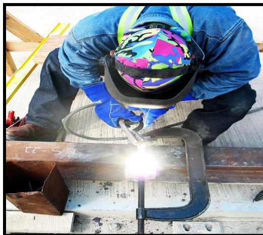
Figura 2.31. Soldeo de una viga en posición 1G
