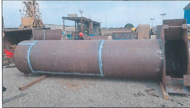
Fotografía N°1: Se observa la cara exterior de las juntas soldadas, en la cual se aplicó el revelador MR 70 como medio de contraste (blanco)
