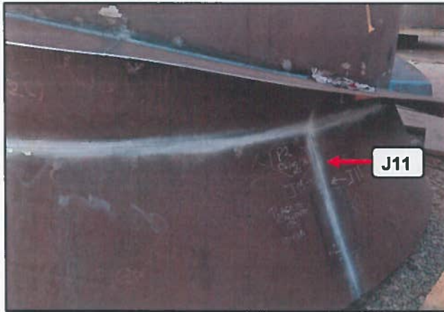
Fotografía N°2: Se observa la cara exterior de la junta soldada a tope J11 sobre la cual se aplicó el revelador MR 70 como medio de contraste (blanco)
