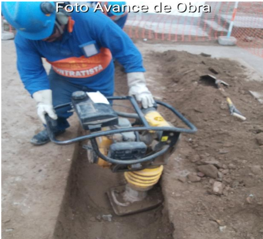
Vibro apisonador utilizado para el compactado del terreno antes de ser reparado con el asfalto.
