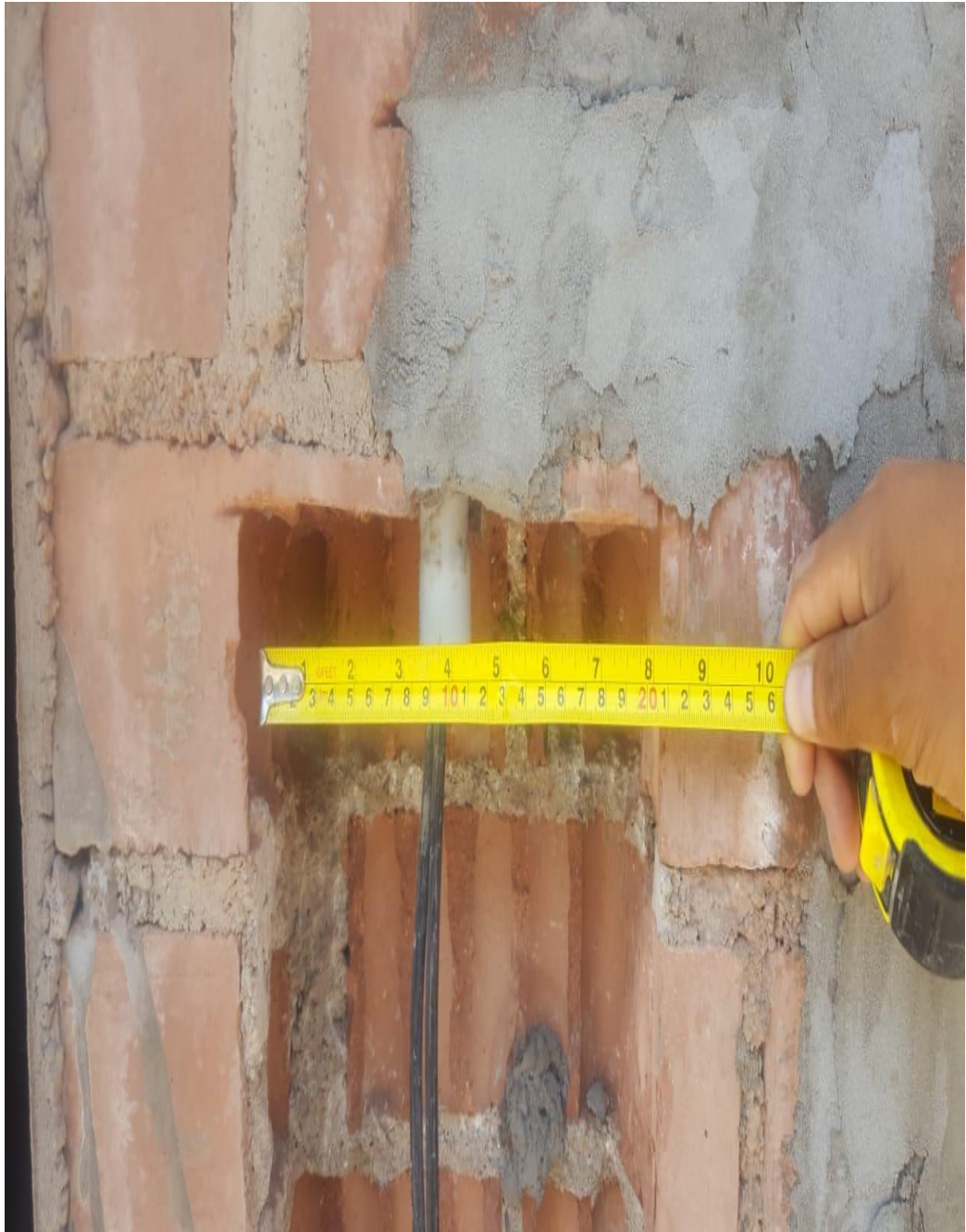
Se observa la longitud de los 20.8 cm de ancho de la cajuela estando dentro de los parámetros establecido por Luz del Sur
