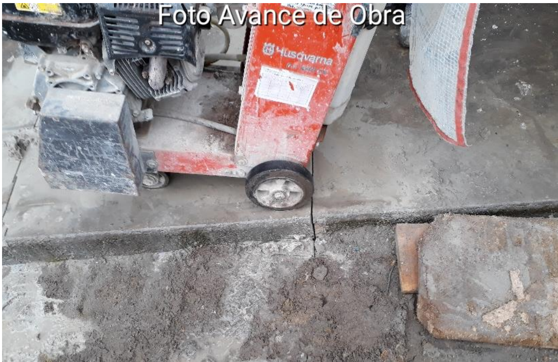
Cortadora mecánica utilizado para realizar la guiar mediante el corte firme para posteriormente romper con el rotomartillo sin afectar las veredas aledañas.
