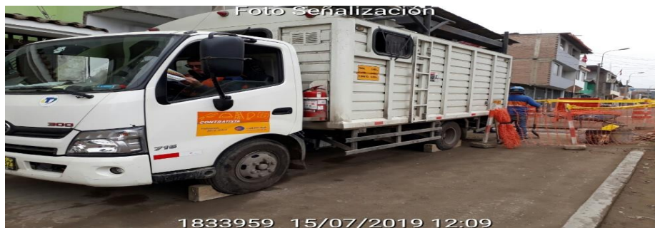
Figura N° 13. Ingreso del camión a la zona.
