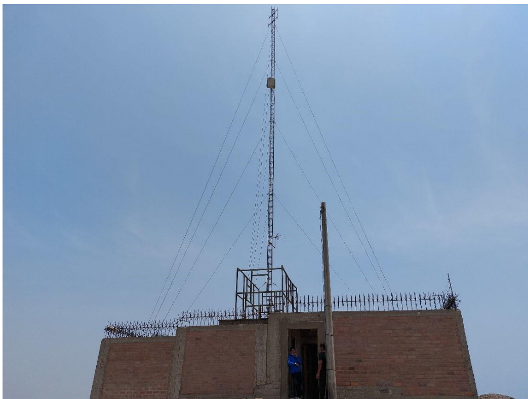
Figura 3.53. Instalación del Sistema Gap-Filler piloto en Cerro Los Perros, Ventanilla.
