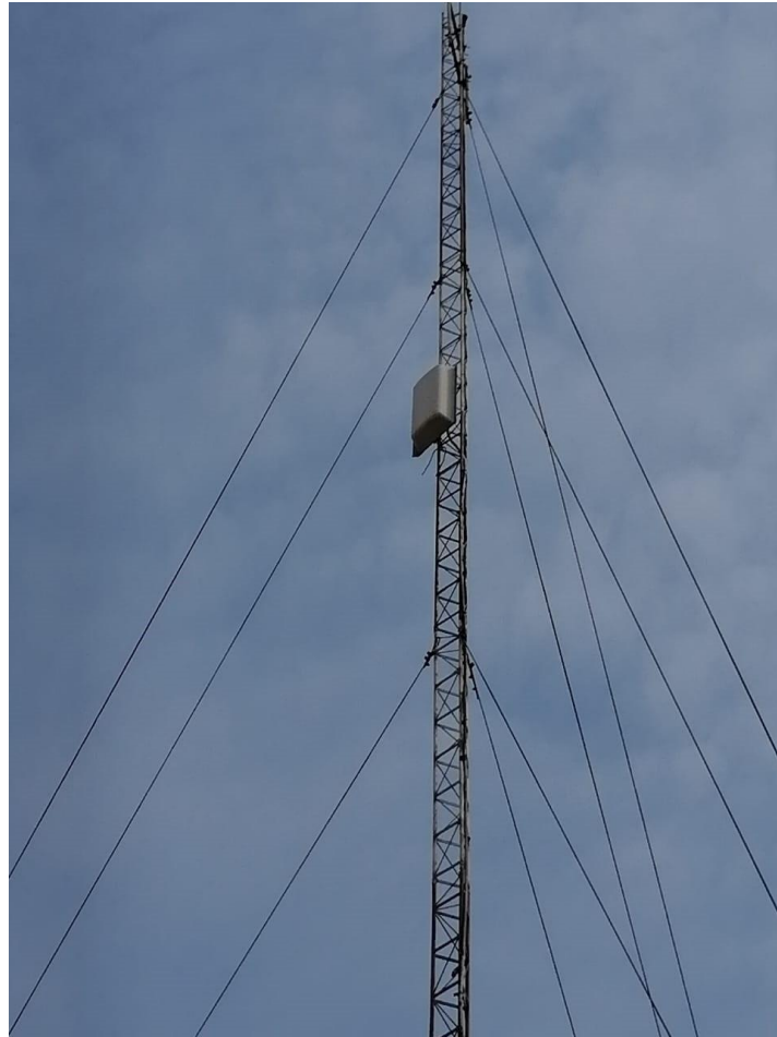
Figura 3.42. Montaje del panel Kathrein en la torre ventada. Fuente: Elaboración propia.
