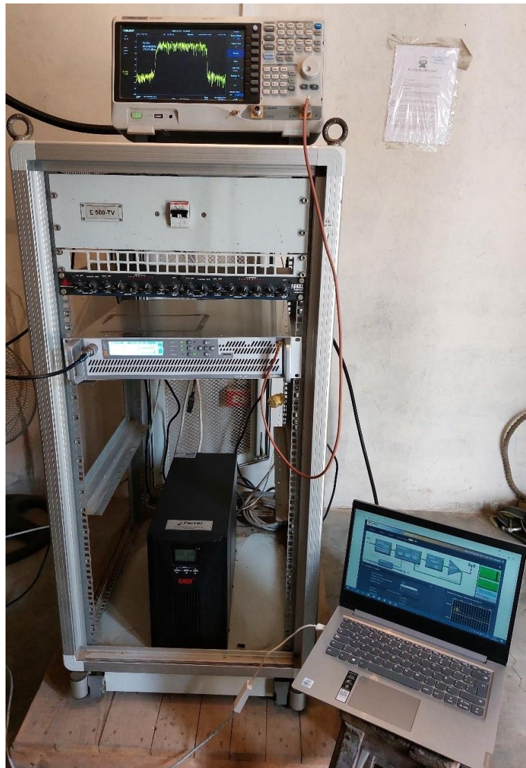
Figura 3.54. Instalación en caseta del sistema Gap-Filler piloto. Fuente: Elaboración propia.
