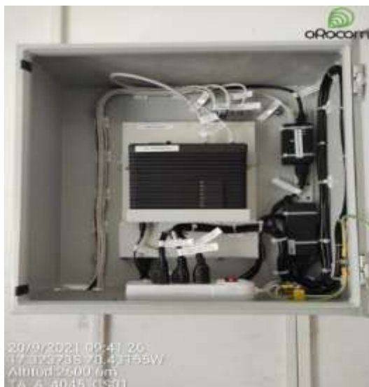
Figura 42 Imagen de la instalación de equipos de red.
