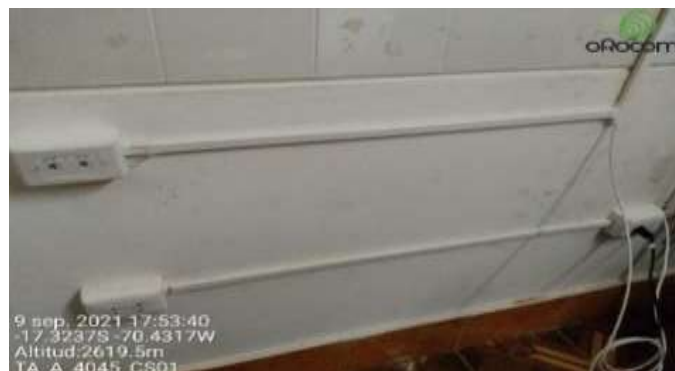
Figura 45 Instalación de los puntos de red
