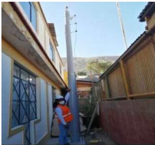
Figura 40 Acabo final de la instalación del mástil
