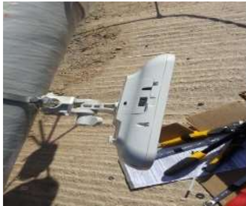
Figura 38 Montaje del receptor PMP450b.
