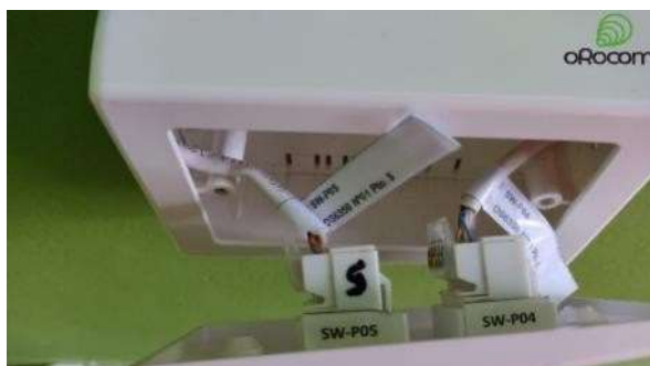
Figura 47 Etiquetado de los puntos de red.
