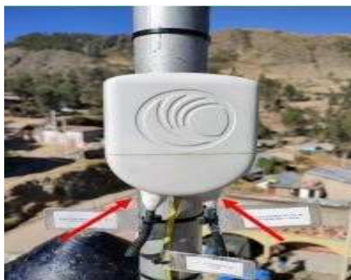
Figura 37 Sellado de las dos entradas del cableado SFTP
