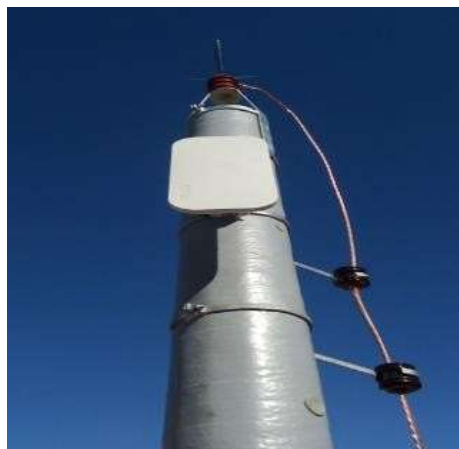
Figura 39 Instalación del tatr puntal y aisladores
