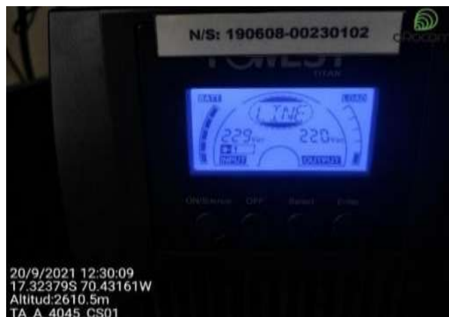
Figura 50 Instalación y encendido del UPS.
