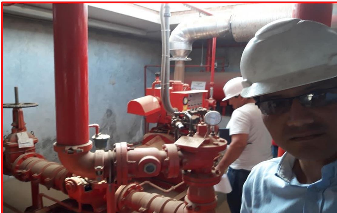
Figura 55: Supervisión de cisterna
