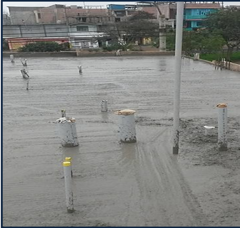
Figura 63: Vaciado de concreto en loza aligerada (acabado final)
