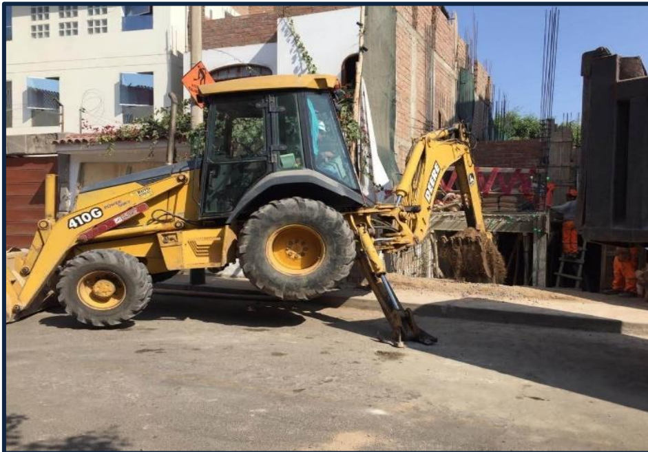
Figura 64: Demolición y eliminación de desmonte
