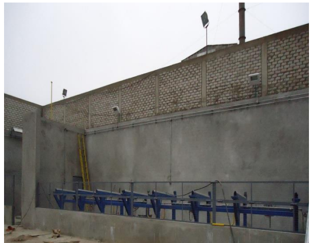
Imagen 18: Instalación de PAD (Ver anexo 13)
