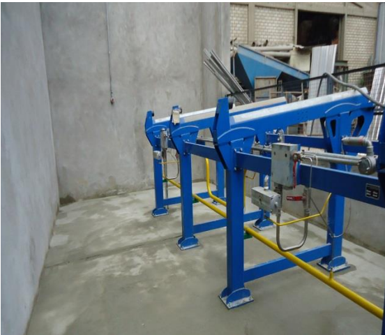
Imagen 17: Instalación de PAD
