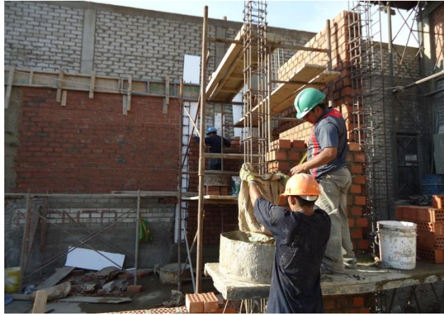
Imagen 16: Desarrollo de obras civiles
