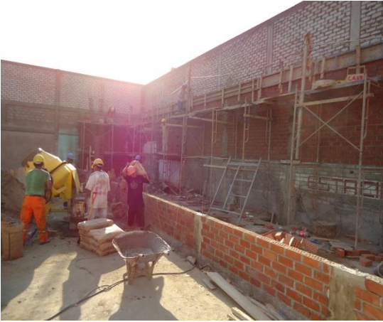
Imagen 15: Desarrollo de obras civiles
