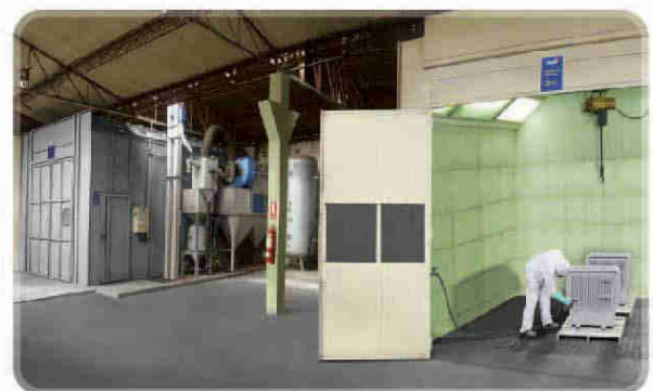
Cabina de Pintura y Granallado
