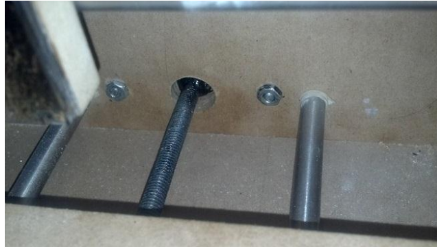
Figura N° 73: Instalación de varilla roscada en eje Y
