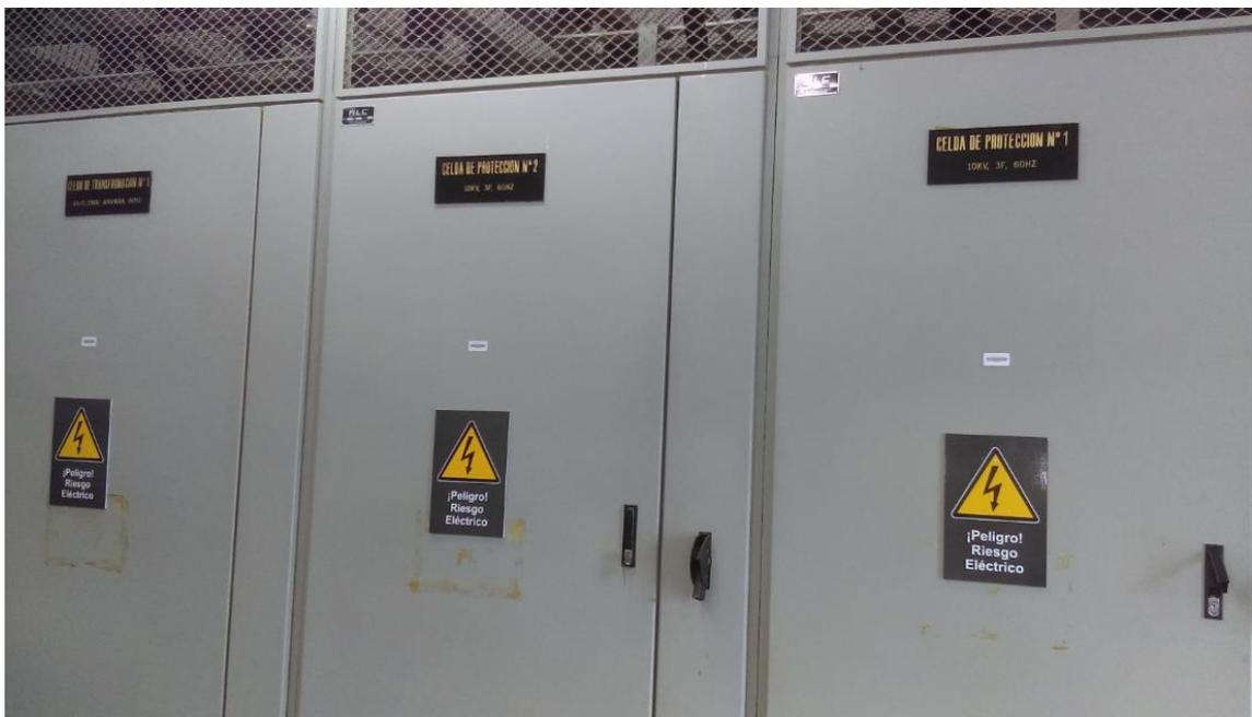
Figura 19: Celda de Transformación N°1, Celda de Protección N° 1 y Celda de Protección N° 2.
