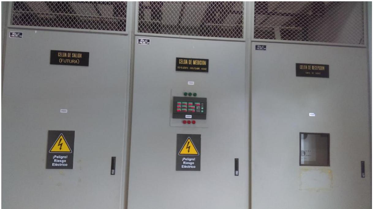
Figura 18: Celda de Salida (Futura), Celda de Medición y Celda de Recepción.
