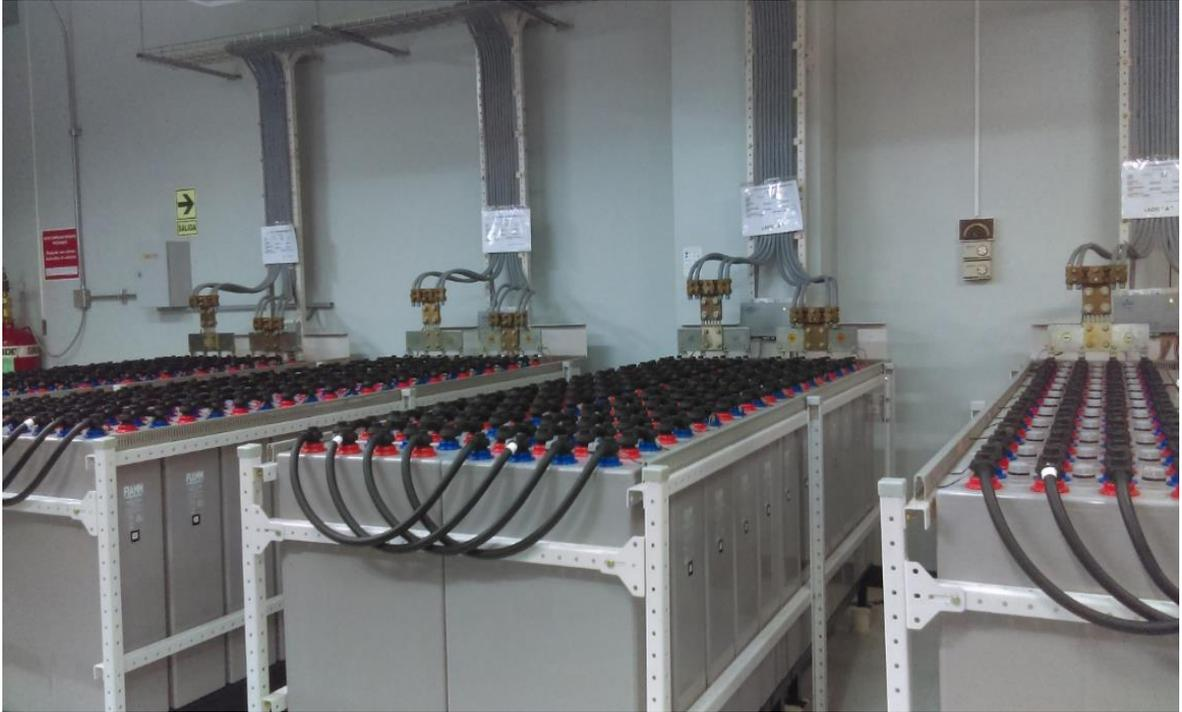
Figura 23: Los 4 filas del Banco de baterías de la planta A conectados en serie y paralelo marca FIAMM SMG2500.
