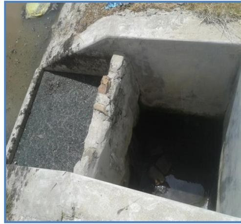
Vertedero de salida de la laguna, como se puede visualizar en la imagen se encuentran fracturadas y completamente obstruido y esto no permite la salida del desagüe tratada.
