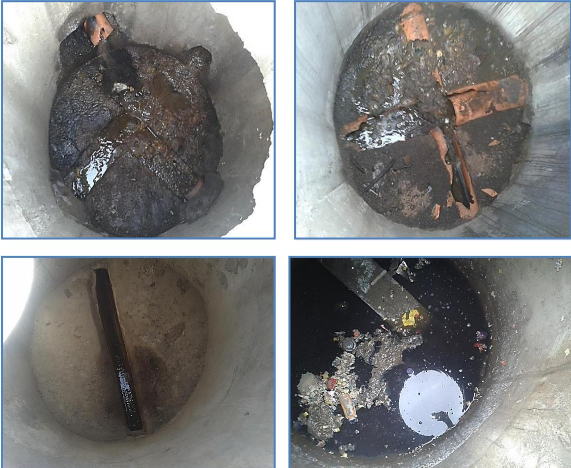
El sistema de recolección de las aguas residuales está colapsado por un mal diseño en los canales de fondo de la mayoría de los buzones. Como consecuencia se puede observar buzones inundados, tuberías rotas y un canaletas completamente obstruidos.
