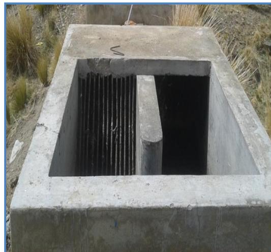
Cámara de rejas: el estado de este componente está deteriorado, las rejillas que sirven para la retención de los sólidos se encuentran oxidadas.
