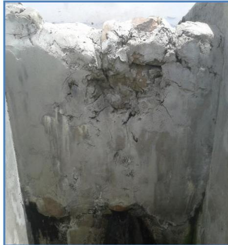
En la imagen de la parte de la izquierda podemos visualizar el buzón de alcantarillado la cual se encuentra en mal estado ,en la imagen de la derecha podemos visualizar roturas del componente, la parte interna de la infraestructura se encuentra en mal estado y con rajaduras en la infraestructura
