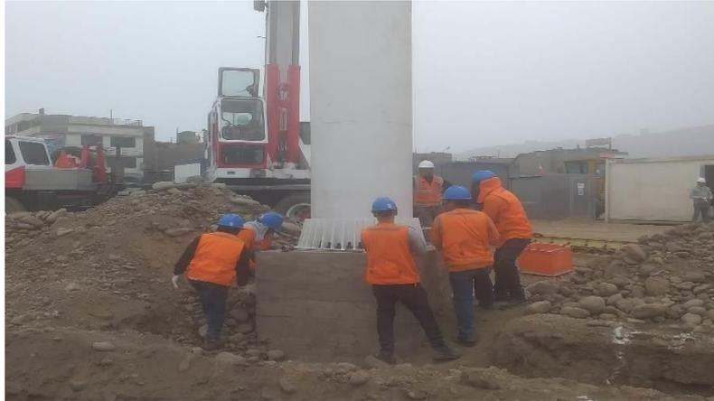
**Figura 7 .** Empernado de la Torre Unipolar al Pedestal
