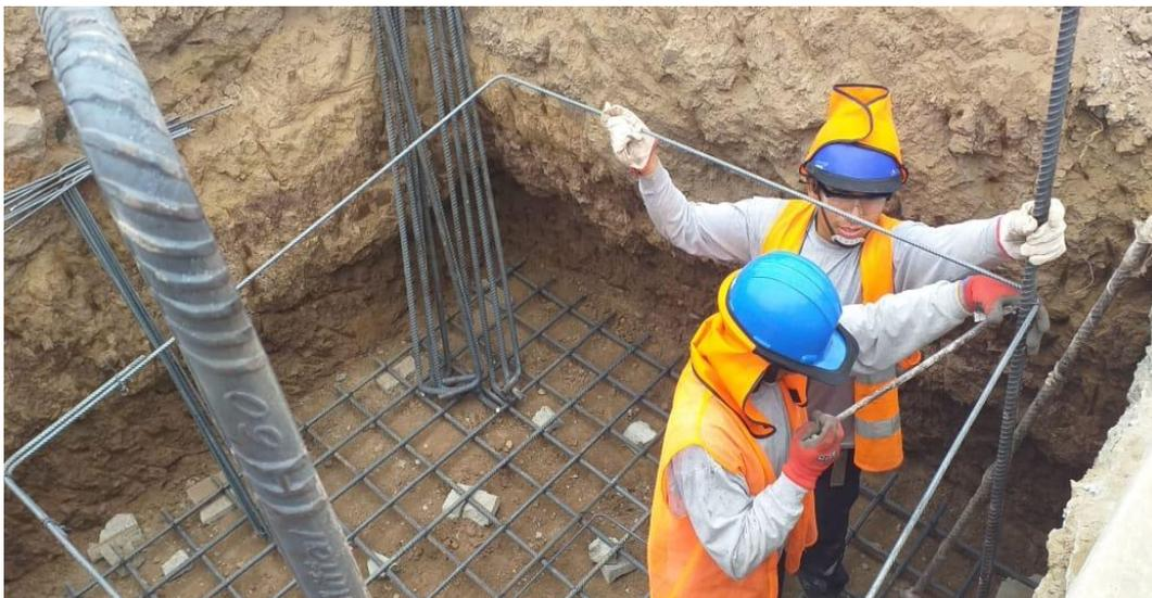
**Figura 2.** Enmallado de la zapata
