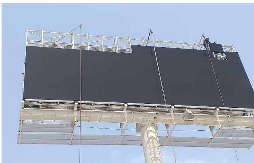
**Figura 10** .Izaje de los Gabinetes a las Canastillas
