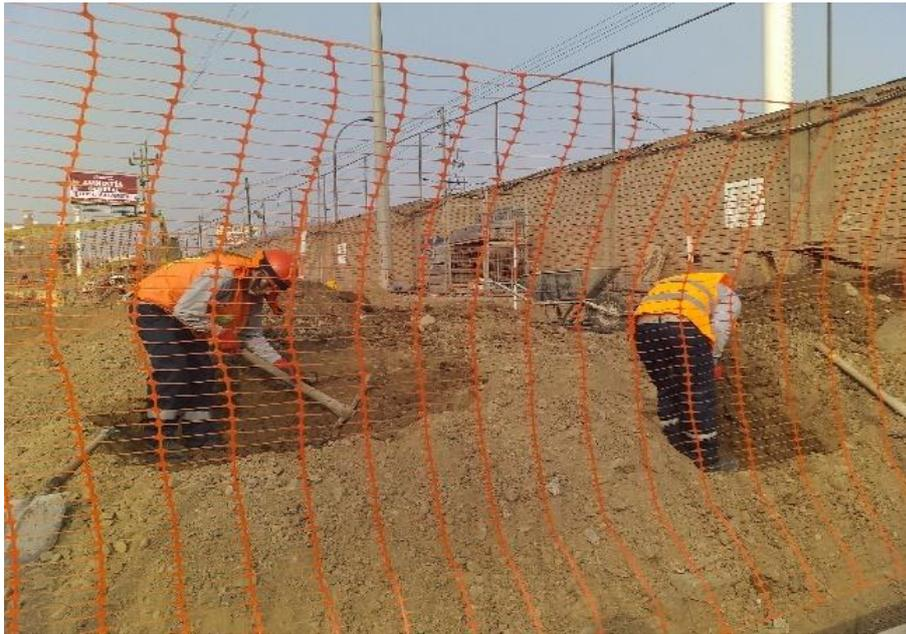
**Figura 1.** Excavación de la zanja
