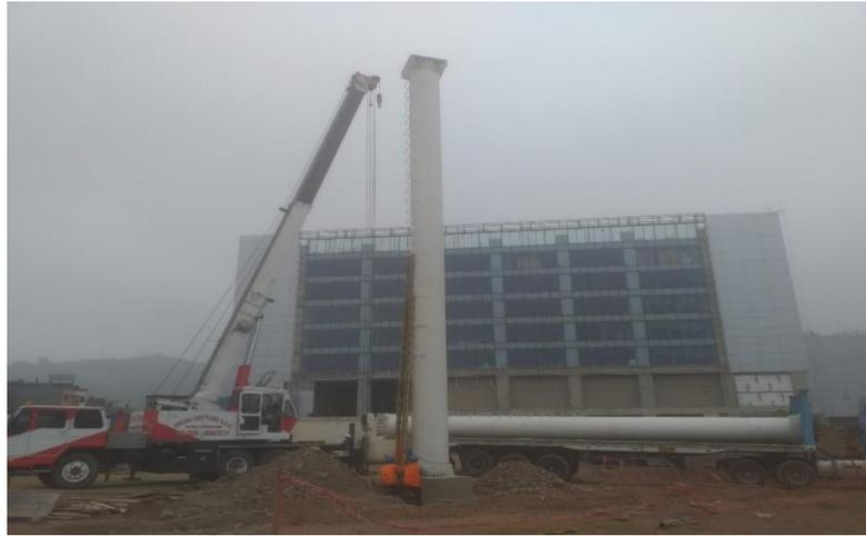
**Figura 6 .** Posicionamiento de la Torre Unipolar
