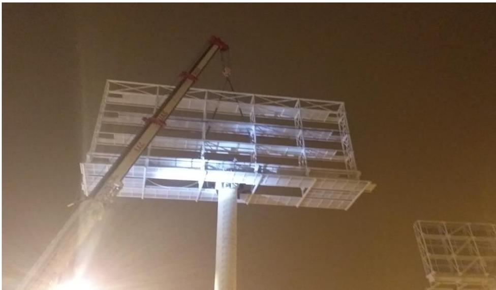
**Figura 9** .Puesta de la Estructura Portapanel
