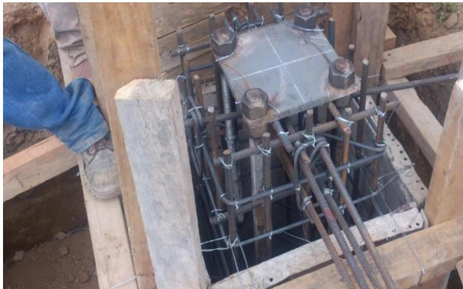
**Figura 3 .** Encofrado de la zapata
