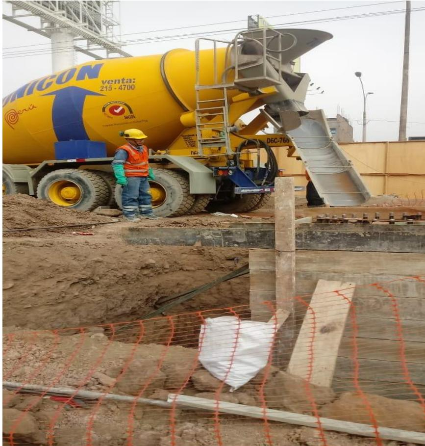
**Figura 4 .** Vaciado de concreto con mixer
