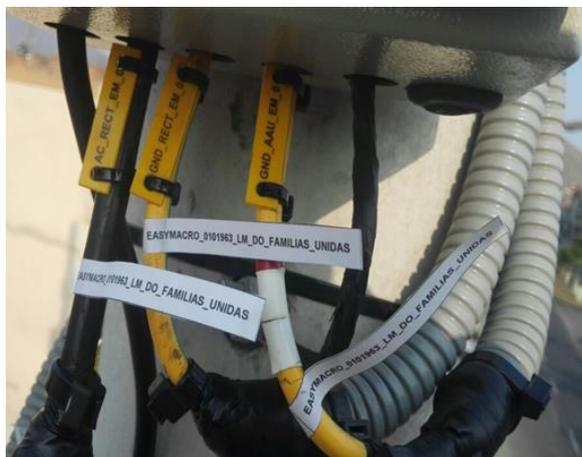
Figura 49. Etiquetado de aterramiento en tablero de distribución
