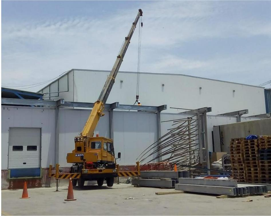
**Anexo 9: Proceso de colocación de pernos estructurales.**
