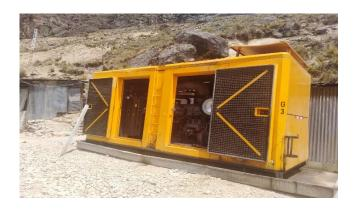
Grupo electrógeno abiertos: requieren de una caseta especial para su operación (ver Figura 4).
