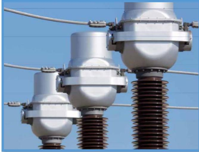
*Figura 9 Transformadores de corriente*
