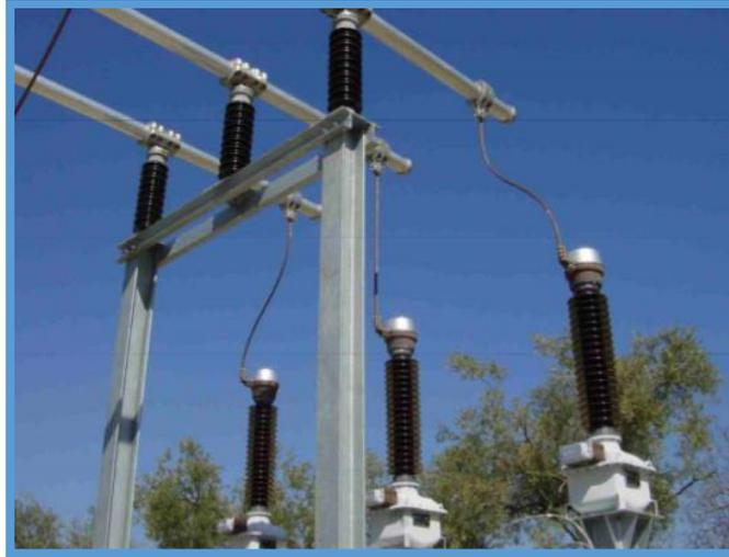
*Figura 8 Transformadores de tensión*
