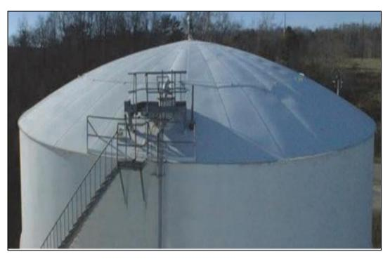
Figura 11: Tanque de Techo Fijo.
