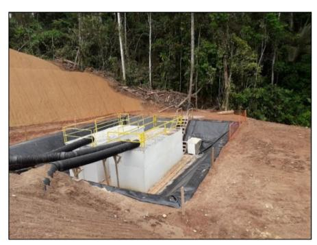
Figura 5: Tanques Bajo Tierra.
