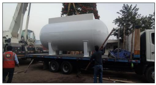
Figura 14: Transporte de Tanques Fabricados en Taller.
