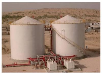
Figura 8: Tanques de Almacenamiento con techo cónico.
