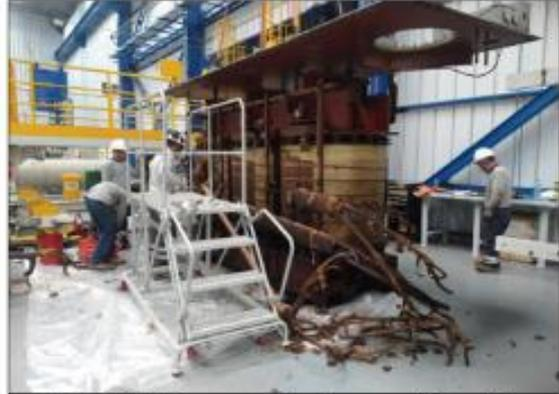
**Foto 04:** Proceso de desmontaje de la parte activa.
