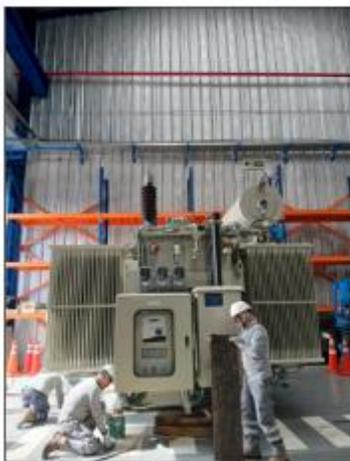
**Foto 40:** Traslado del transformador a zona de despacho.
