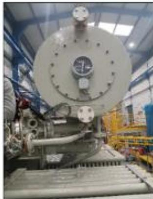
**Foto 31:** Montaje de tanque conservador y relé Buchholz.
