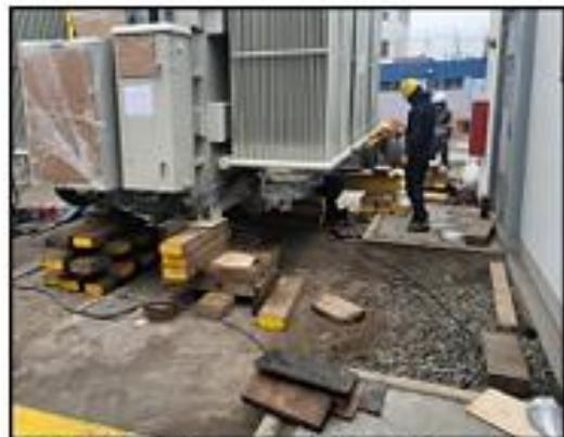
Foto 05: Descarga del transformador.
