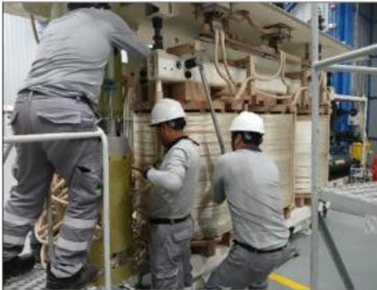
**Foto 18:** Conexionado y proceso de torque en pernería de parte activa.
