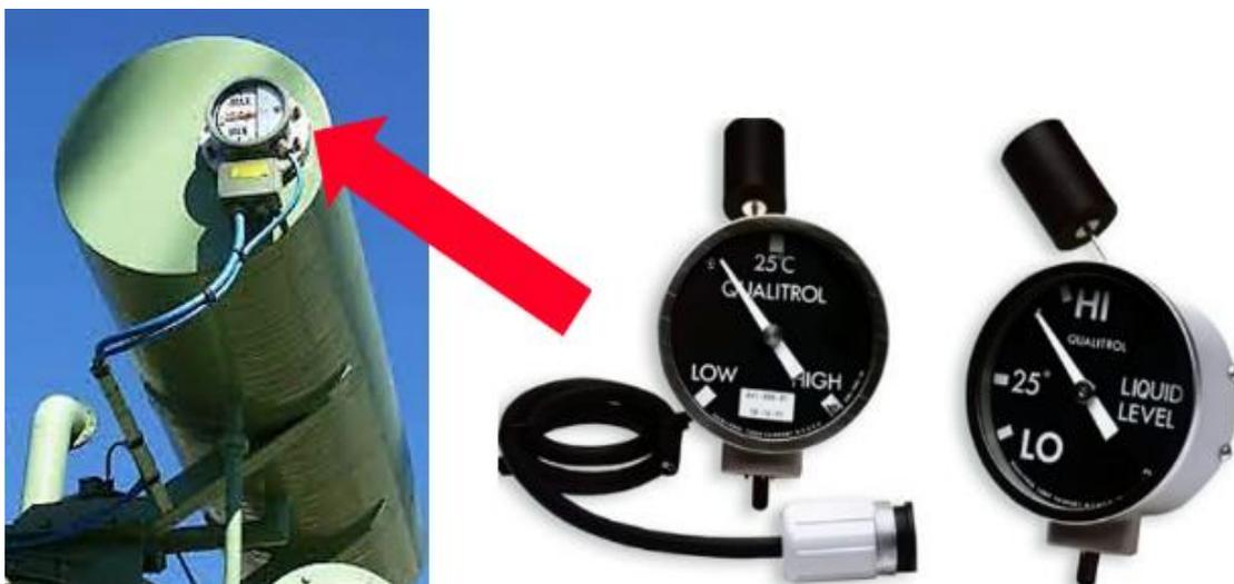
*Nota.* Indicador de nivel de aceite tipo radial del transformador montado sobre tanque conservador. Fuente: elaboración propia.
