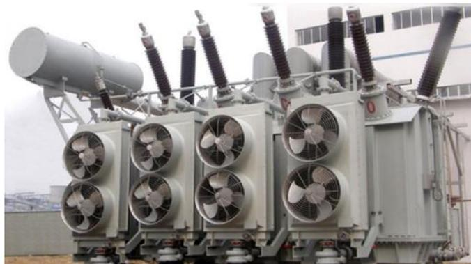
*Nota.* Sistema de refrigeración tipo ONAF para un transformador de potencia superior a los 16 MVA. Fuente: GlobeCore (2024).
