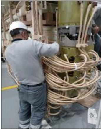
**Foto 17:** Conexionado del OLTC suministrado por Hitachi Energy.
