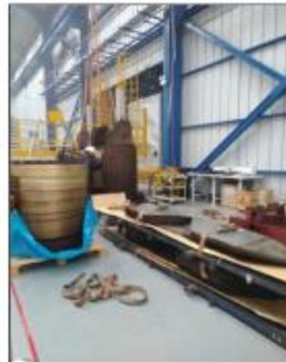
**Foto 05:** Retiro de las bobinas del núcleo magnético.
