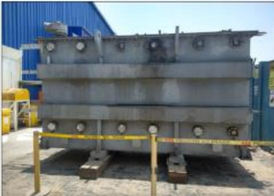
**Foto 02:** Desmontaje de accesorios.
