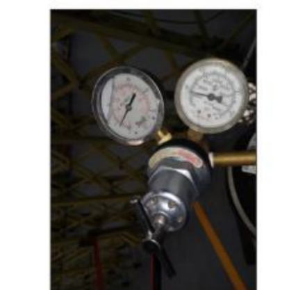
Foto 32: Presurización con aire seco a 3 PSI.
