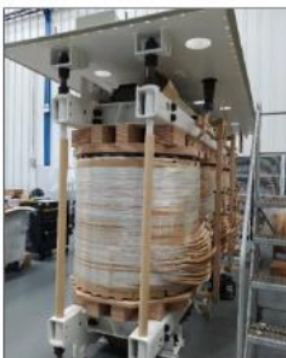
Foto 15: Montaje de la tapa del transformador.
