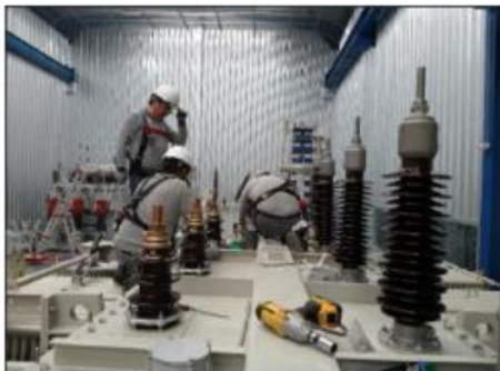
Foto 29: Montaje de bushing de AT, válvula de seguridad, bloque de conexión de TC's, etc.
