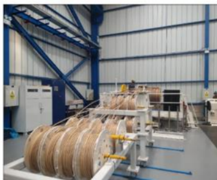
Foto 10: Proceso de fabricación de bobinas AT y BT.
