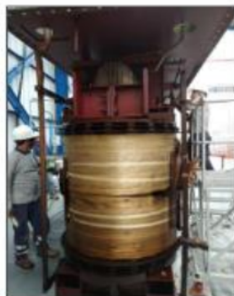
Foto 03: Desencubado de la parte activa para su posterior desmontaje.
