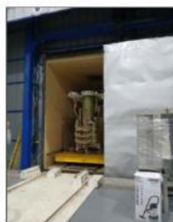
Foto 27: Retiro de parte activa del horno autoclave.
