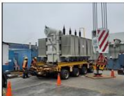
Foto 01: Izaje del transformador sobre el transporte de carga.
