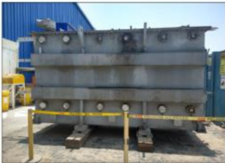
Foto 02: Desmontaje de accesorios.
