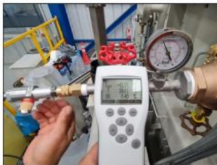
Foto 33: Medida de punto de rocío, inferior a 0.5% la HR.
