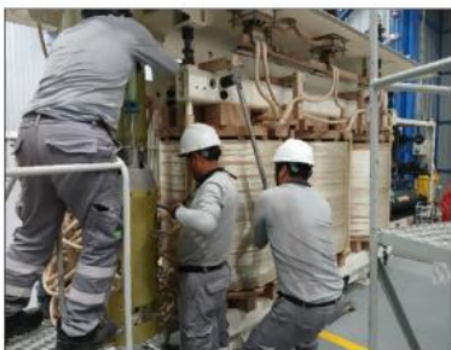
Foto 18: Conexión y proceso de torque en pernería de parte activa.
