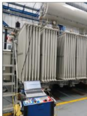
Foto 36: Tratamiento de aceite por termovacío.
