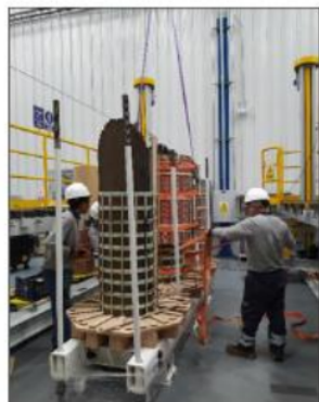
Foto 13: Montaje de bobinado AT y BT.
