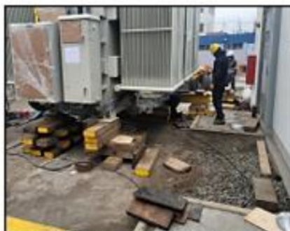
Foto 05: Descarga del transformador.
