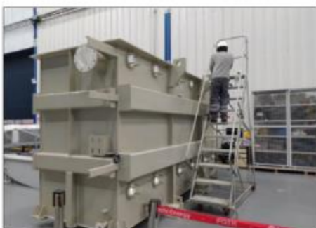
Foto 24: Preparación de tanque para el montaje de todos los accesorios.
