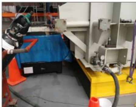
Foto 36: Tratamiento de aceite por termovacío.
