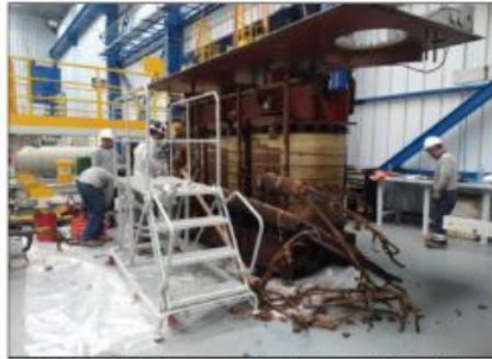
Foto 04: Proceso de desmontaje de la parte activa.
