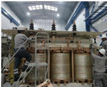
Foto 20: Montaje de TC's y bushing de BT.
