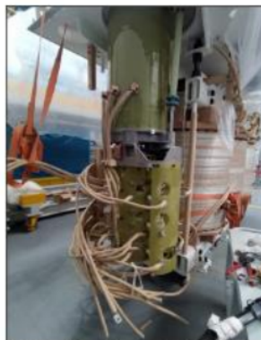
Foto 16: Montaje de OLTC.
