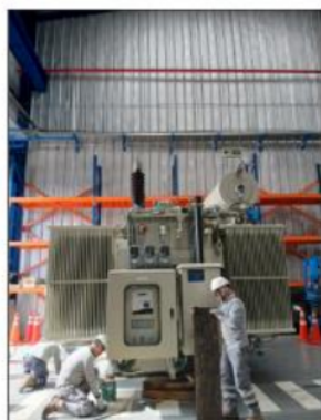
Foto 40: Traslado del transformador a zona de despacho.
