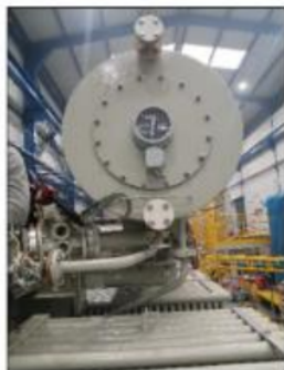
Foto 31: Montaje de tanque conservador y relé Buchholz .
