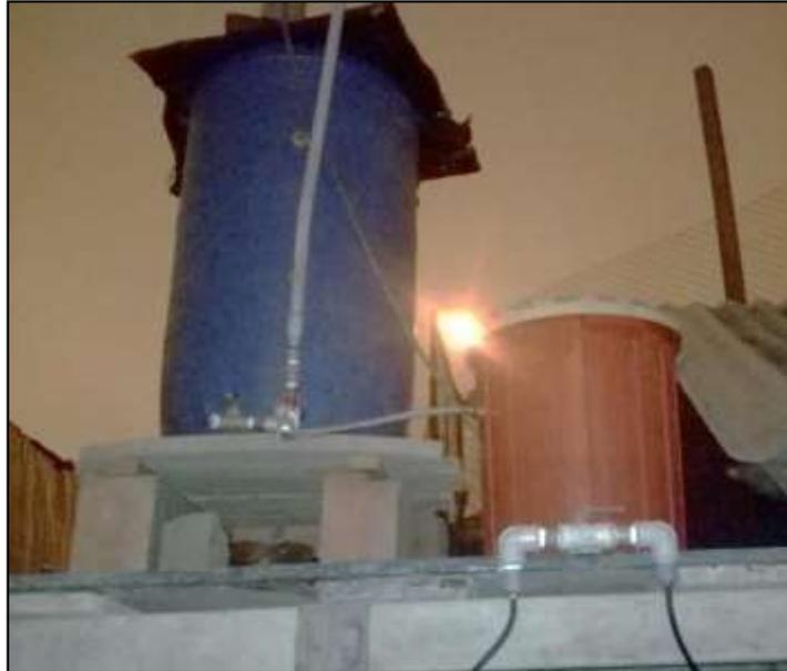
**Figura 14** Sistema de almacenamiento, tanque de Regulación de caudal y un distribuidor de caudal.
