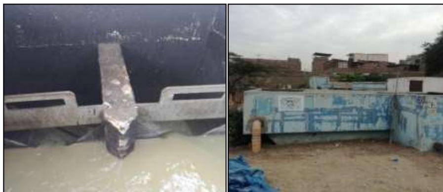
**Figura 5** *Reactor Anaerobio de manto de lodos de Flujo Ascendente*
