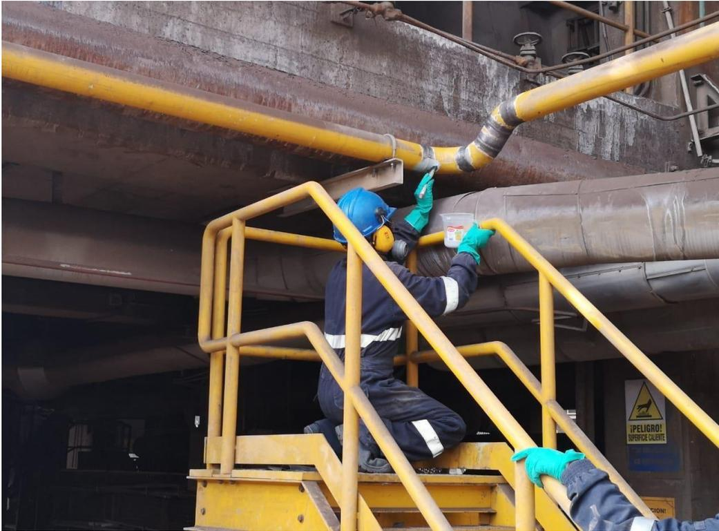
*Figura 6. Pintado de tubería*
