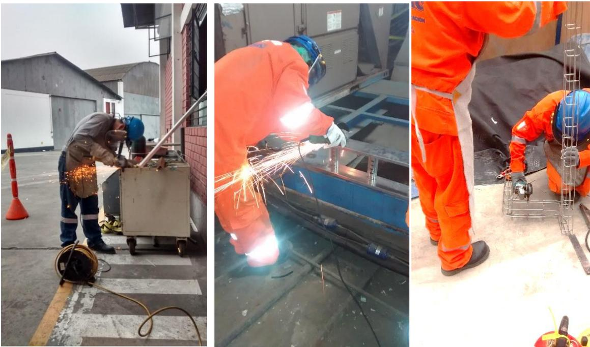
Corte de piezas metálicas, mediante el uso de esmeril- DEPRODECA – PROYECTO GEA (PLANTA NESTLÉ)
