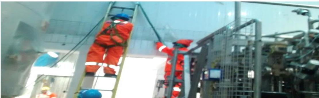
Instalación de bandejas y /o rejillas (por el cual tenderán y peinarán cables), mediante el uso de escaleras - PROYECTO GEA (PLANTA NESTLÉ).
