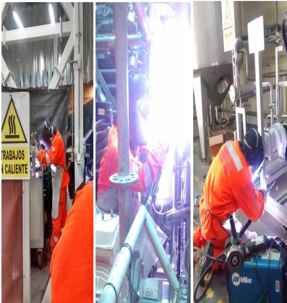
Soldadura TIG de componentes metálicos, posteriormente utilizados para el tendido de rejillas- PROYECTO GEA (PLANTA NESTLÉ)
