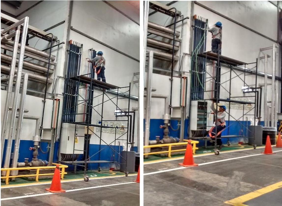
Instalación de tubería conduit y tendido de cables a través de ella-
