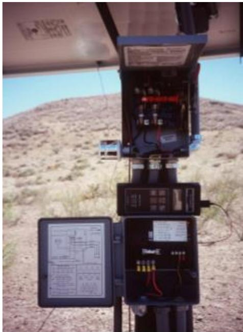
**Figura 16:** Controlador de un sistema fotovoltaico de bombeo
