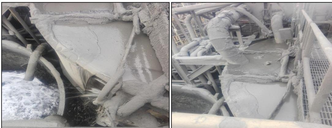
**Figura 60:** Derrame de relave del Holding Tank
