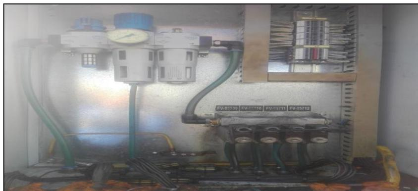
**Figura 62:** Tablero de control neumático
