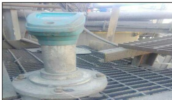
**Figura 66:** Sensor de nivel Sultan instalado en tanque
