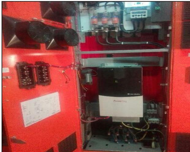
**Figura 68:** Tablero de bomba de alimentación
