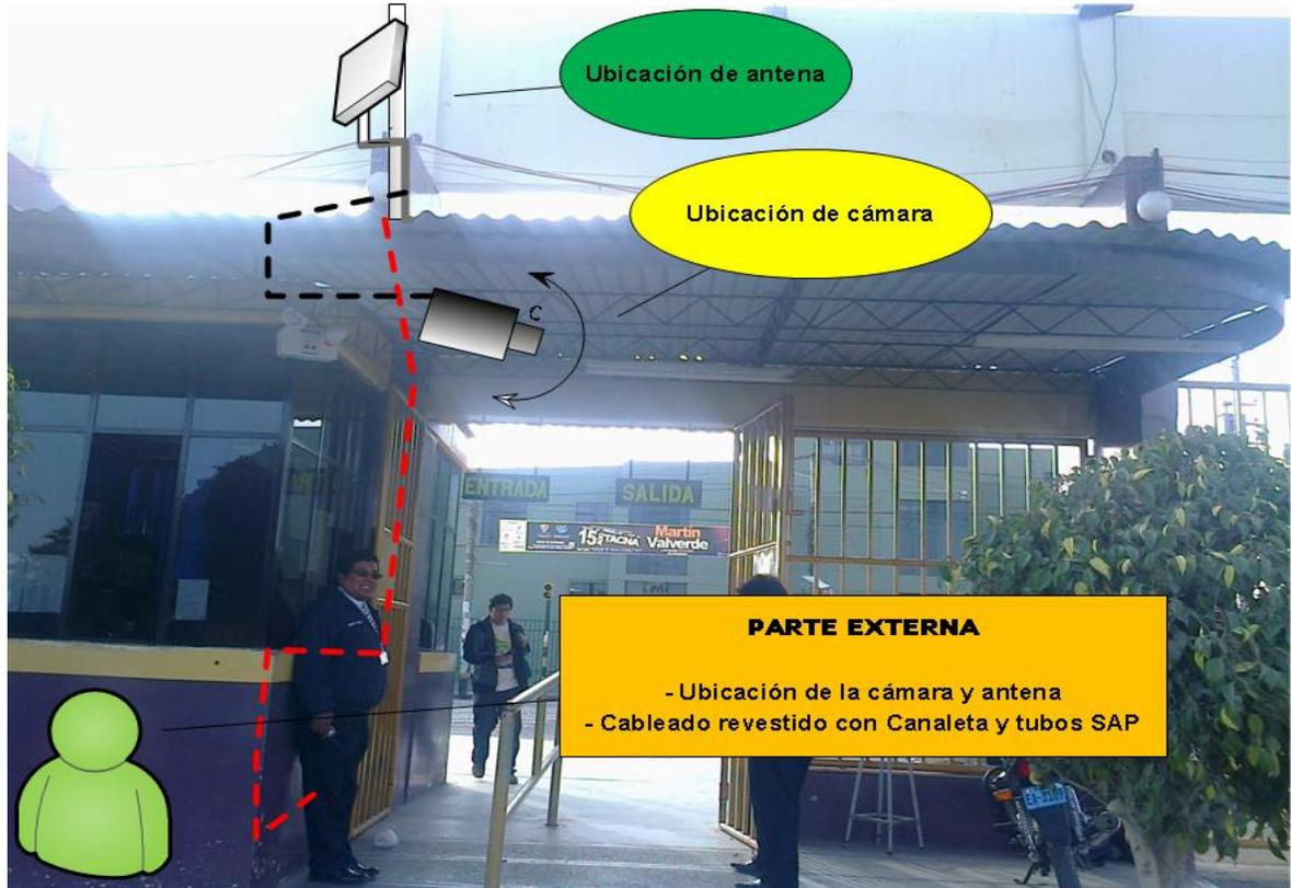
**Ilustración 40:** Ubicación de Antena y Cámara en la puerta principal
