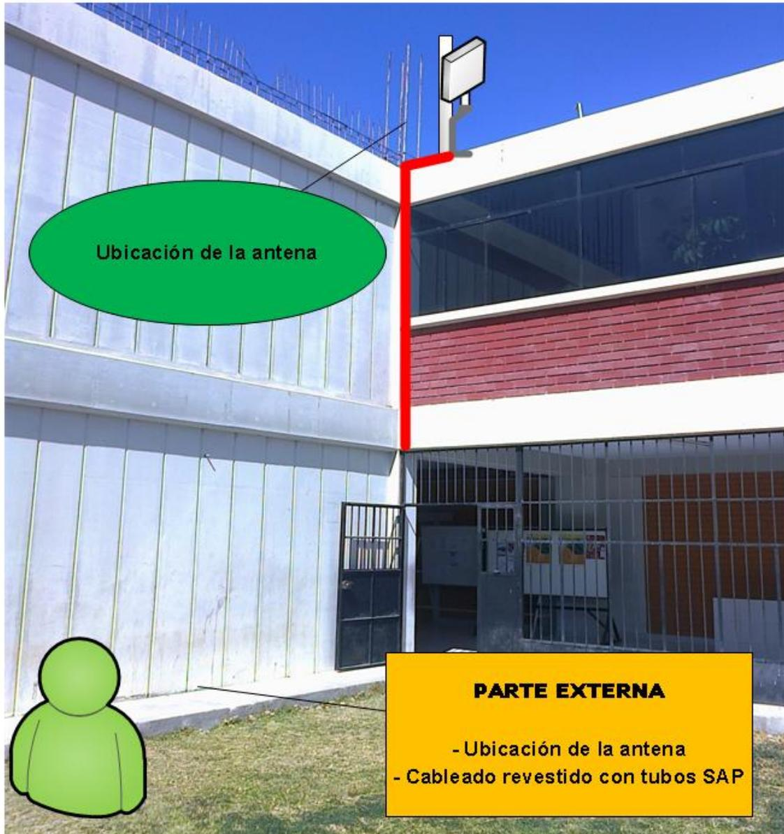
**Ilustración 43:** Ubicación de Antena en el edificio Alimentarias
