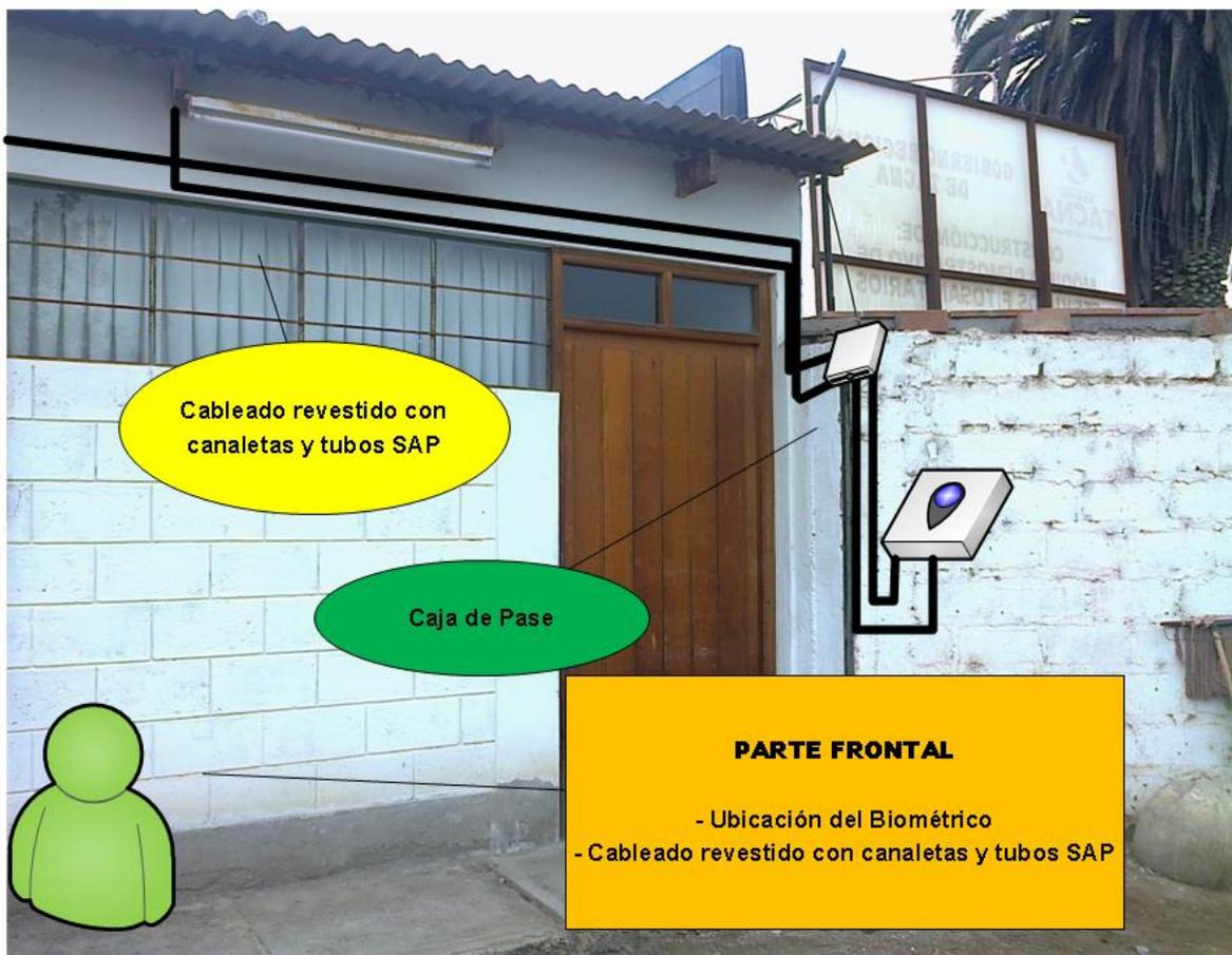
**Ilustración 34:** Ubicación del Biométrico en Inprex
