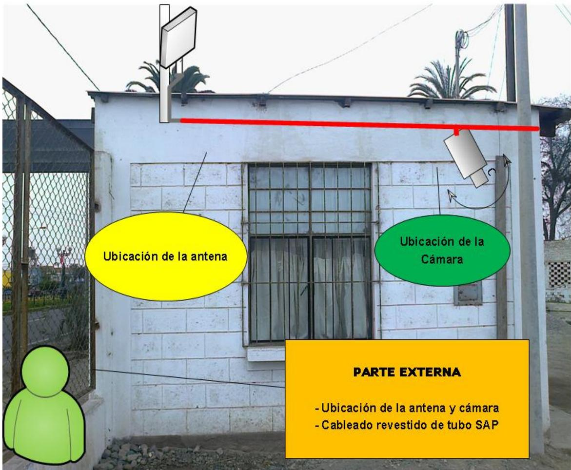
Ilustración 48: Ubicación de Antena y Cámara en Inprex
