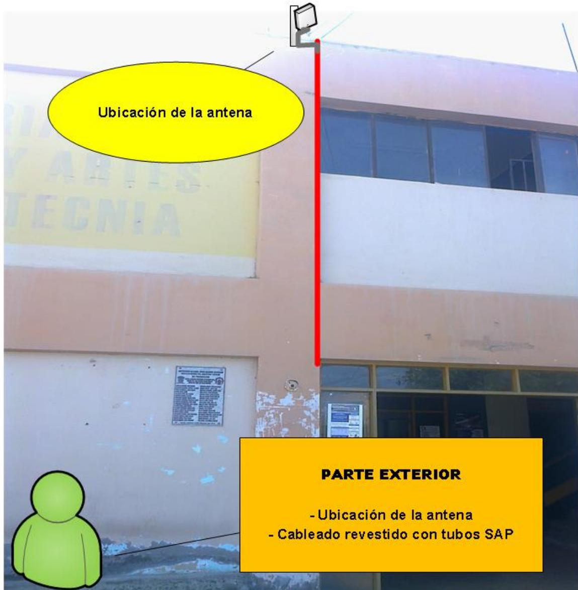
**Ilustración 45:** Ubicación de Antena en el edificio Arquitectura
