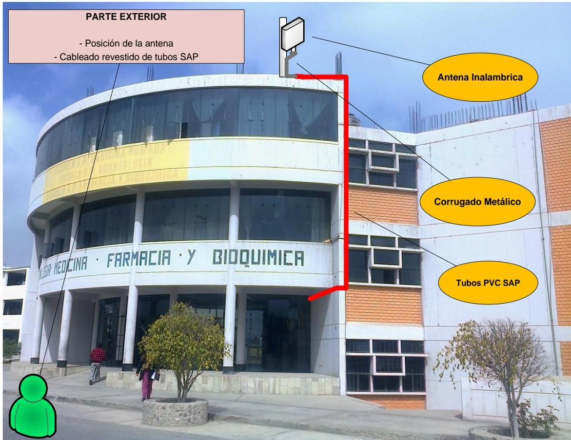
**Ilustración 38:** Ubicación de Antena en el edificio Salud
