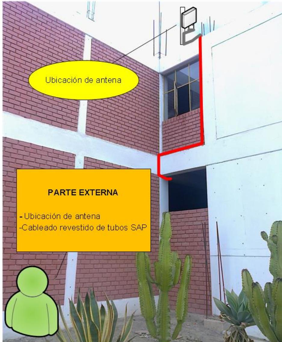
**Ilustración 44:** Ubicación de Antena en el edificio Minas
