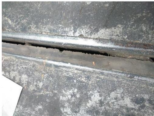
Fig. 2. Deformación de junta del piso
