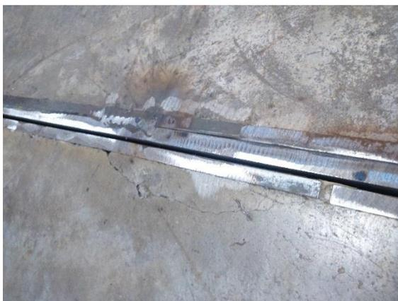
Fig. 14. Soldadura de platina entre las juntas
