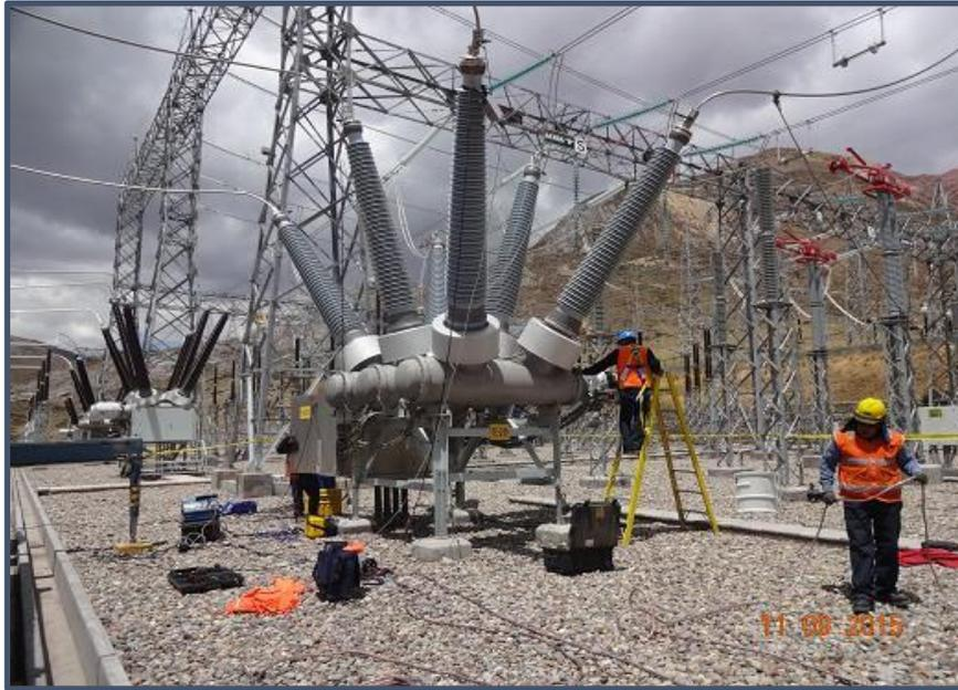
**Imagen 03.** Proceso de pruebas eléctricas del interruptor DTB 245 kV
