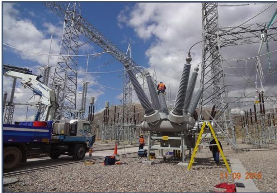
**Imagen 04.** Inspección de los mecanismos unipolares del interruptor DTB 245 kV
