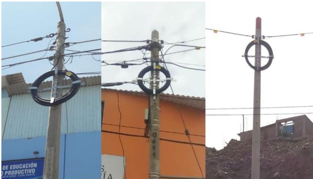
Figura 26 Reservas colocadas en infraestructura de Hidrandina S.A., TDP y Entel Perú
