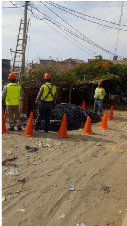
Figura 25 Ejemplo de señalización del área de trabajo.
