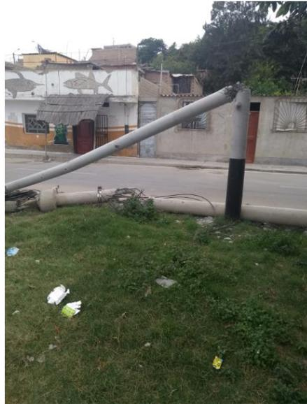
Figura 21 Poste de concreto de 9 metros de altura quebrado.
