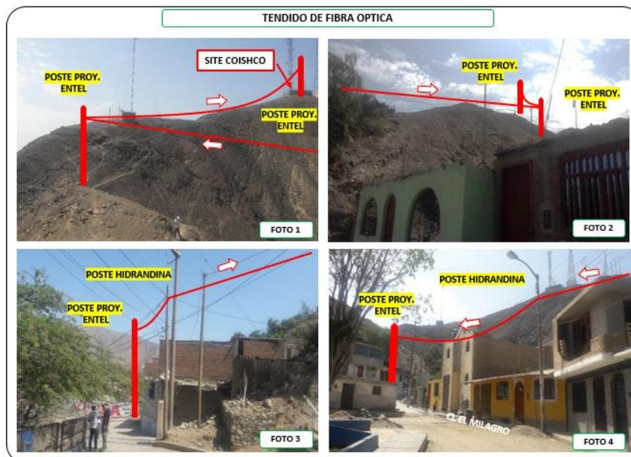
Figura 9 Validación del diseño en campo culmina en el *Site* Coishco (Distrito de Coishco)
