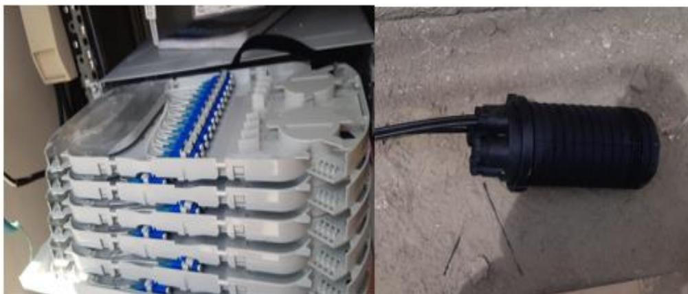
Figura 27 ODF de 96 puertos y Caja de empalme de 96 hilos
