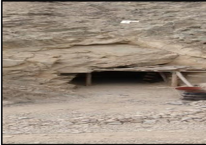
Nota: En la imagen se muestra la entrada a bocamina estabilizada con puntales de madera (foto proporcionada por MINERA MAPSA)
