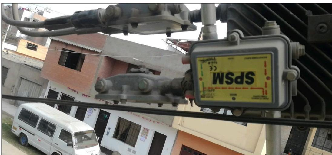
*Figura 36. Instalación del sistema Multiswitch en la Pext*
