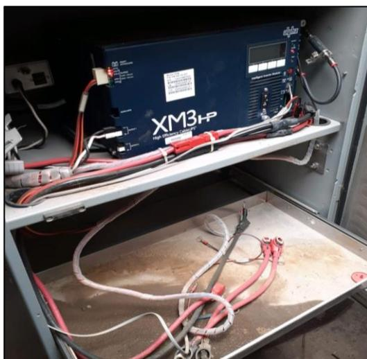
*Figura 35. Estado físico de la Fuente LMJL024*
