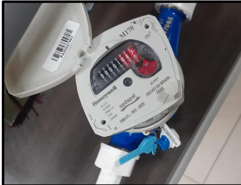
**Figura 22** Medidor de agua Elster M170.
