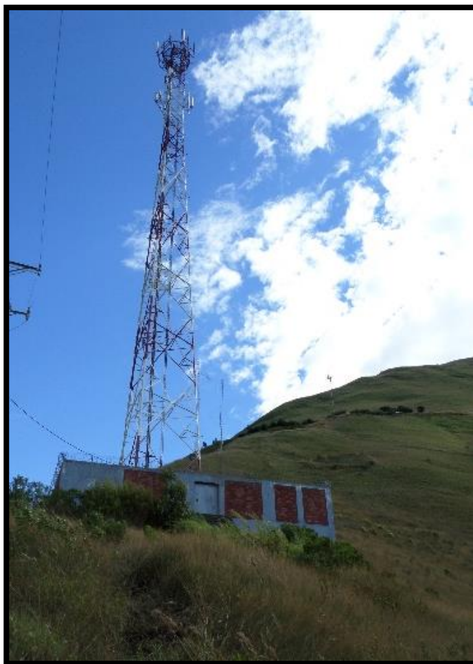
FIGURA 3-1: FOTO PANORAMICA DEL SITE SANTA TERESA
