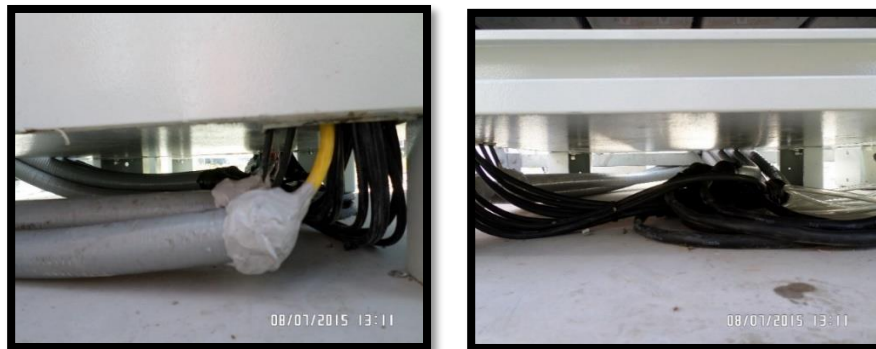
FIGURA 3-24: Pasamuro de los Gabinetes en el site Santa Teresa
