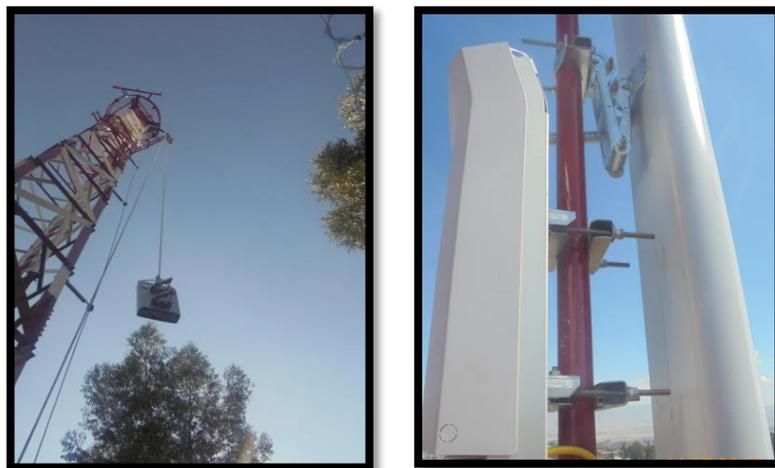
**FIGURA 3-25:** IZAJE DE LA RRU (IZQUIERDA) / ANCLAJE DE LA RRU (DERECHA).
