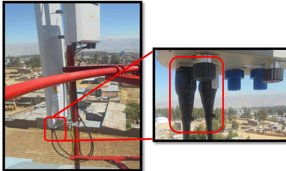
**FIGURA 3-26:** JUMPERS ENTRE ANTENA Y RRU (ISQUIERDA)
