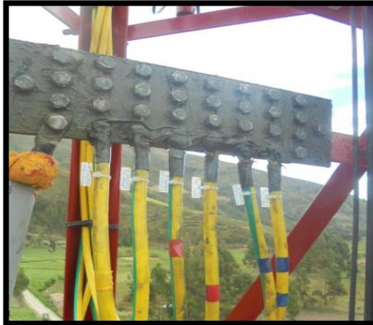
**FIGURA 3-32:** BARRA DE ATERRAIETO DE LOS EQUIPOS.
