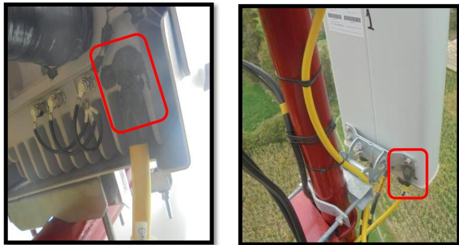
**FIGURA 3-31:** ATERRAMIENTO DE LA RRU (IZQUIERDA)
