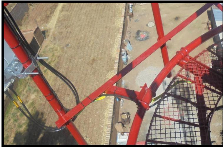
**FIGURA 3-28:** PEINADO DEL CABLE DE ENERGÍA SOBRE LA ESTRUCTURA.
