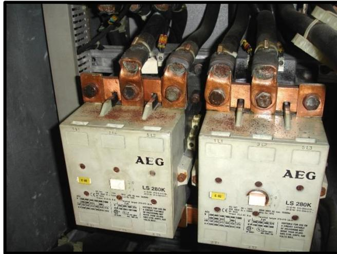
*Figura 2.* Sistema de arrancador para un motor.
