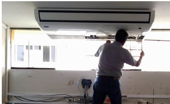
Figura 45. Instalación sistema climatización Fuente: Elaboración propia
