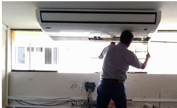
Figura 43.Instalación sistema climatización Fuente: Elaboración propia
