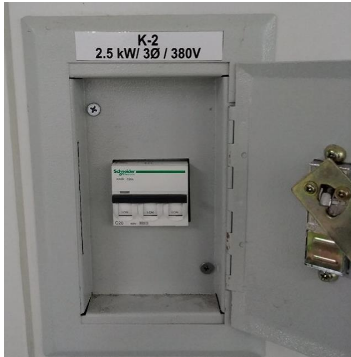
Figura 41. Punto de tierra para el sistema Fuente: Elaboración propia
