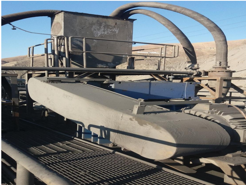
Figura 2.12. Tanque principal de relaves Fuente: elaboración propia
