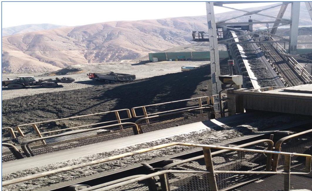
Figura 2.17. Fajas transportadoras para relave y traslado de camiones Fuente: Elaboración propia
