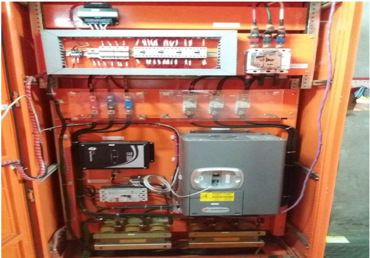
Figura 3.18. Componentes eléctricos del arrancador Fuente: Elaboración propia
