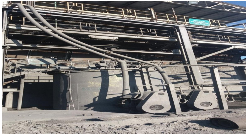
Figura 2.19. Tanque de recuperación de agua Fuente: Elaboración propia
