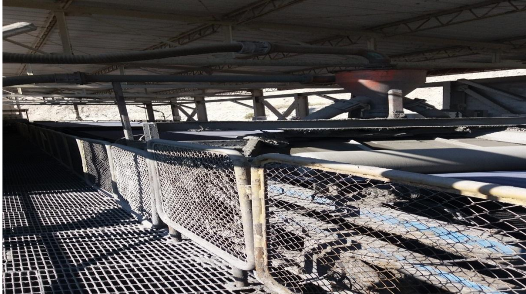
Figura 2.14. Relave enviado a los filtros banda Fuente: Elaboración propia
