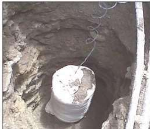
Figura 17. Instalación de ánodo de magnesio.
