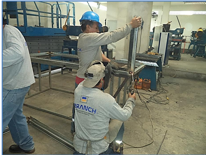
Figura 34: Unión de perfiles estructurales por soldadura eléctrica Fuente: Elaboración Propia – BRANCH S.A.C
