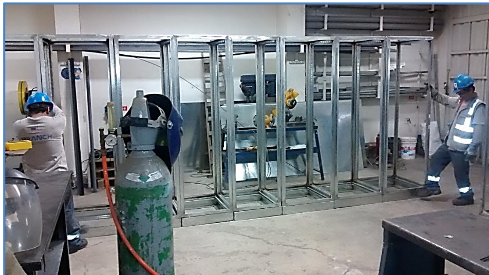
Figura 41: Perfiles estructurales acoplados sobre sus zócalos Fuente: Elaboración Propia – BRANCH S.A.C
