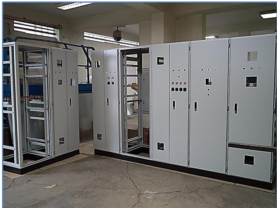
Figura 54: Tablero Eléctricos en proceso de ensamblado Fuente: Elaboración Propia – BRANCH S.A.C
