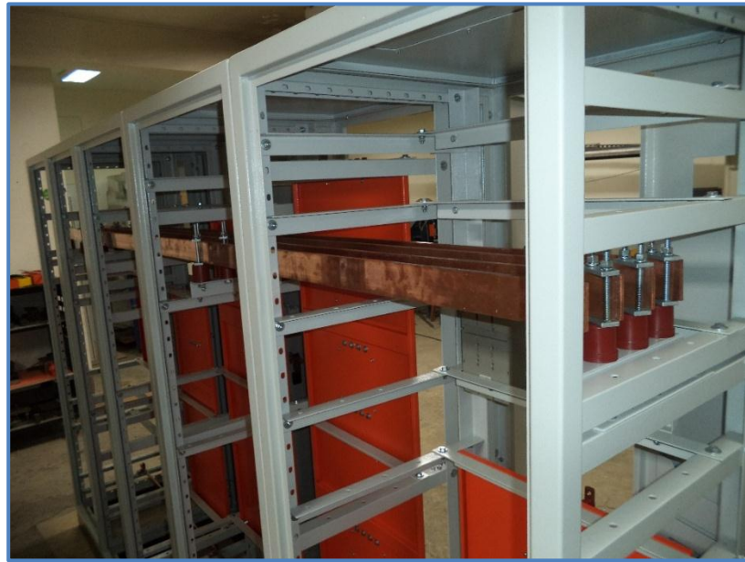
Figura 52: Ensamblado de 3.3 m de barra de Cu de 1100 a Fuente: Elaboración Propia – BRANCH S.A.C
