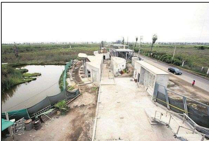
Figura 11 Construcción de Mirador, Fuente: Tatiana Gamarra, Pantanos de Villa están en estado de abandono, 3 de febrero del 2015
