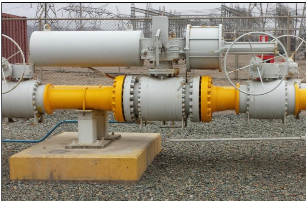
FIGURA 13 - TRIP VALVE EN ERM
