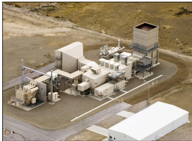
FIGURA 10 - PLANTA DE ENERGÍA DE CICLO SIMPLE
