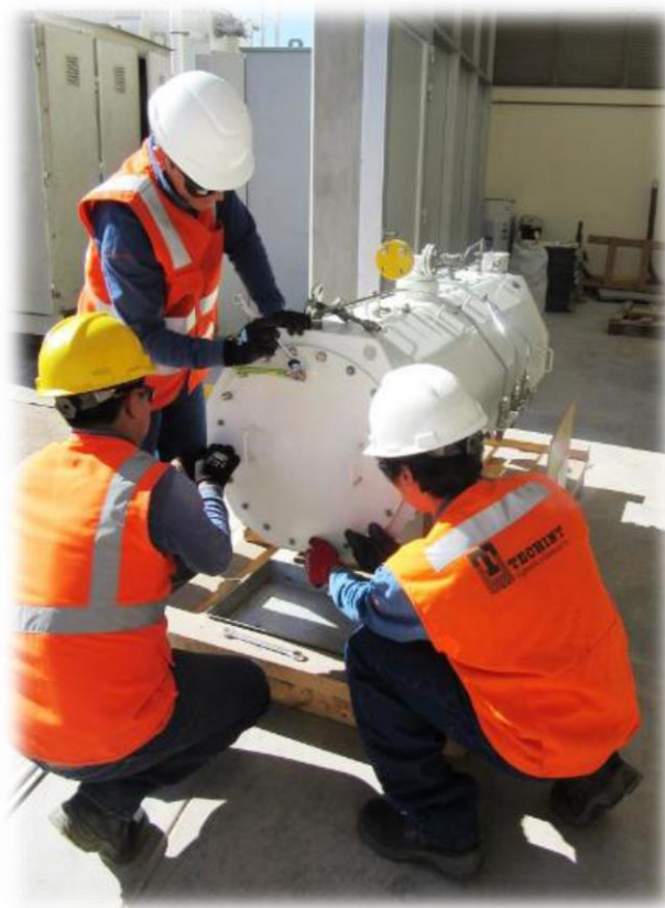
Foto 3. Tanque conservador, inspección de bolsa pronal.
