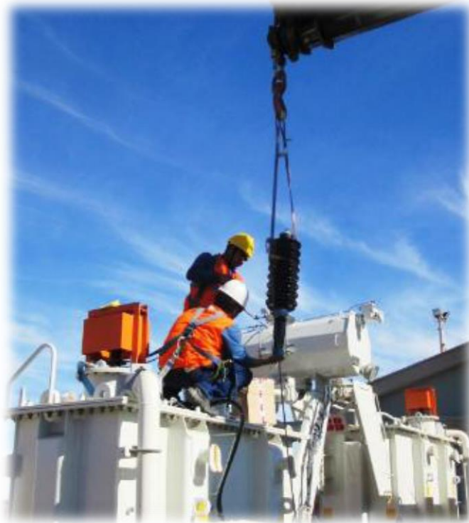
Foto 5. Montaje del tanque conservador y aislador.
