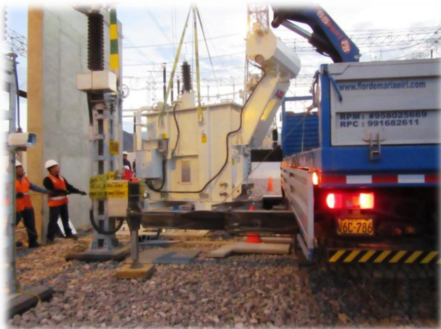
Foto 11. Carga del reactor Nuevo de 30KVAR.
