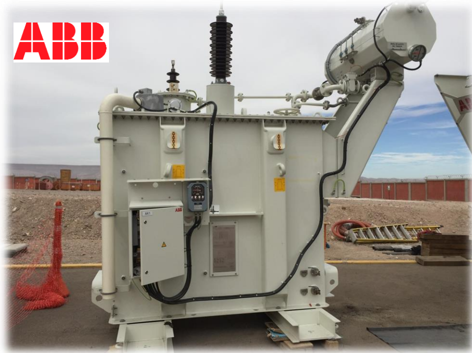
Figura 5. Reactor neutro 30KVAr, marca ABB
