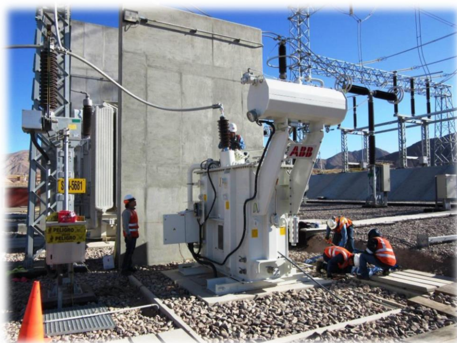
Foto 13. Vista del reactor nuevo de 30KVAR en la sub estación Montalvo.
