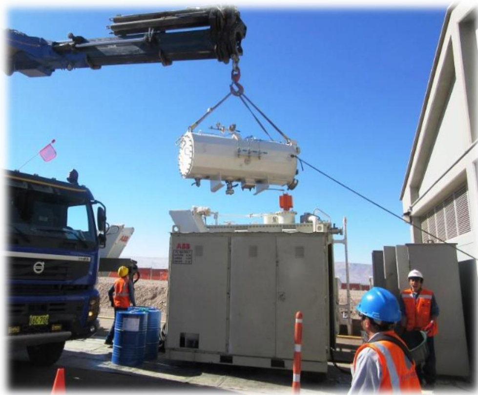
Foto 5. Montaje del tanque conservador y aislador.
