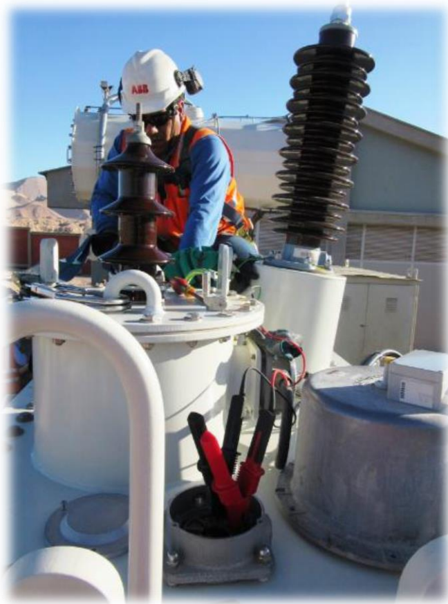
Foto 11. Carga del reactor Nuevo de 30KVAR.
