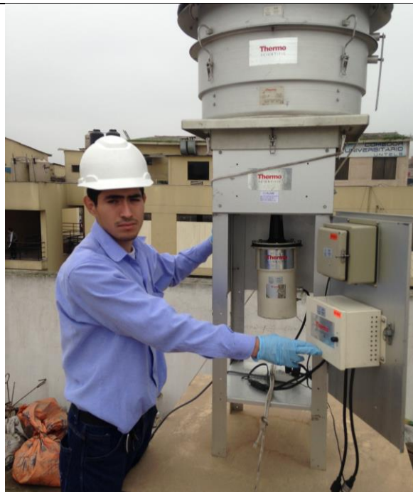
Pabellón A – Cuarto Piso - UNTELS
