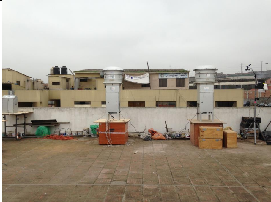
Pabellón A – Cuarto Piso - UNTELS
