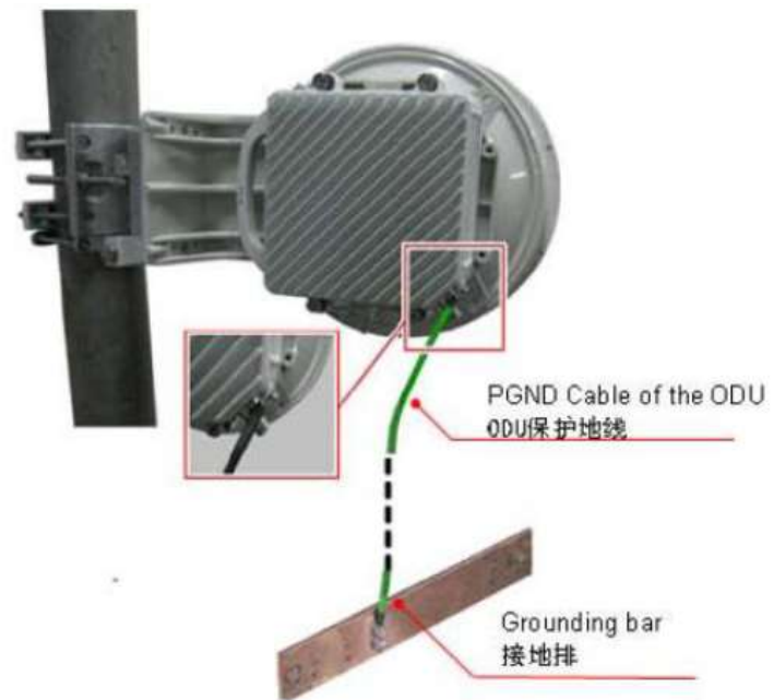
Figura 3.38: Aterramiento a la barra.
