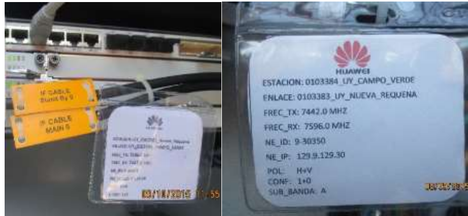
Figura 3.23: Rotulado de IDU RTN 950A instalada en cada cable coaxial.
