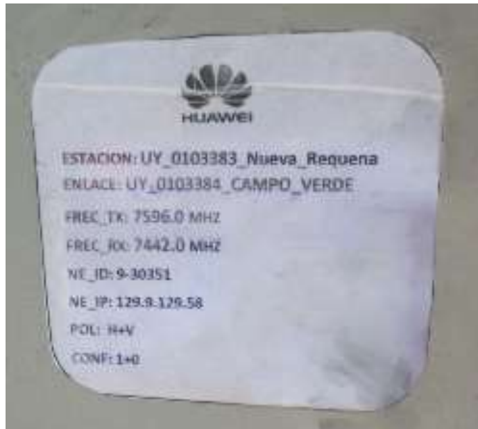
Figura 3.25: Rotulado de la antena con etiqueta autoadhesiva.
