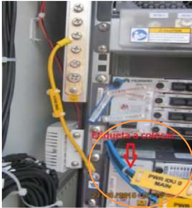
Figura 3.19: Etiquetado de IDU a Breaker (MAIN).
