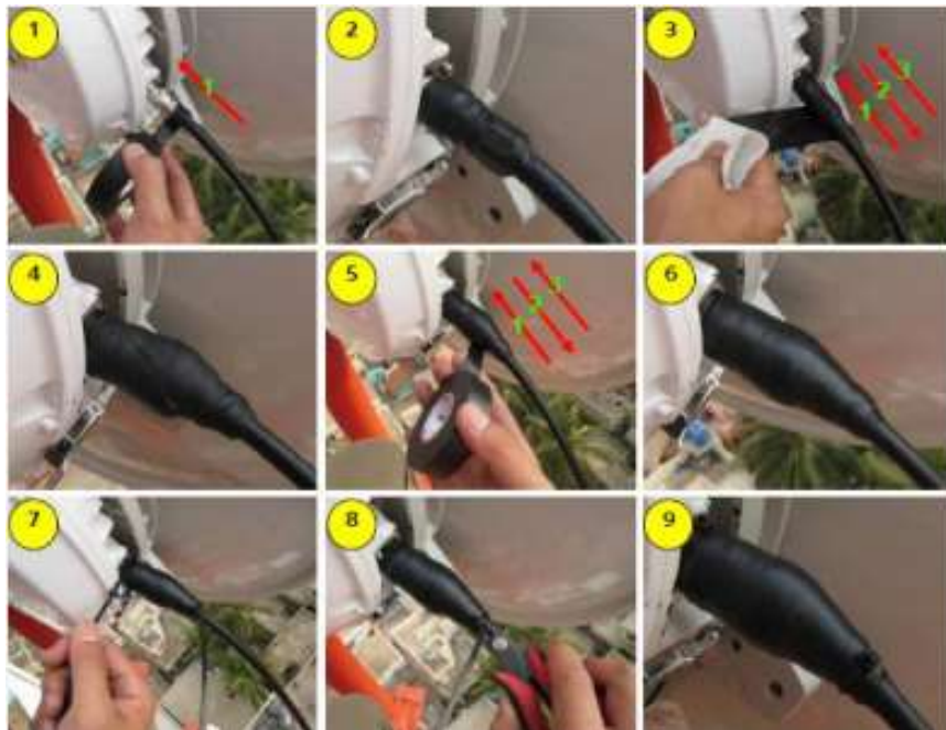
Figura 3.15: Vulcanizado del conector.
