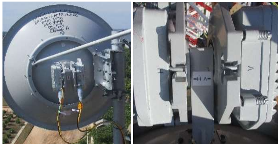
Figura 3.35: Montaje de Antena y colocación de la ODU.
