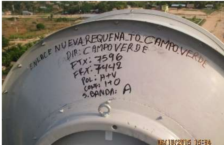
Figura 3.24: Rotulado de Antena con plumón indeleble.
