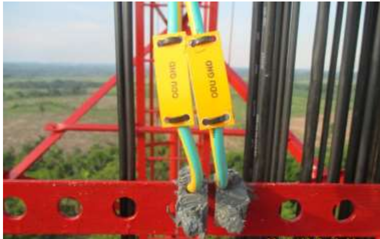
Figura 3.39: Aterramiento a la barra.
