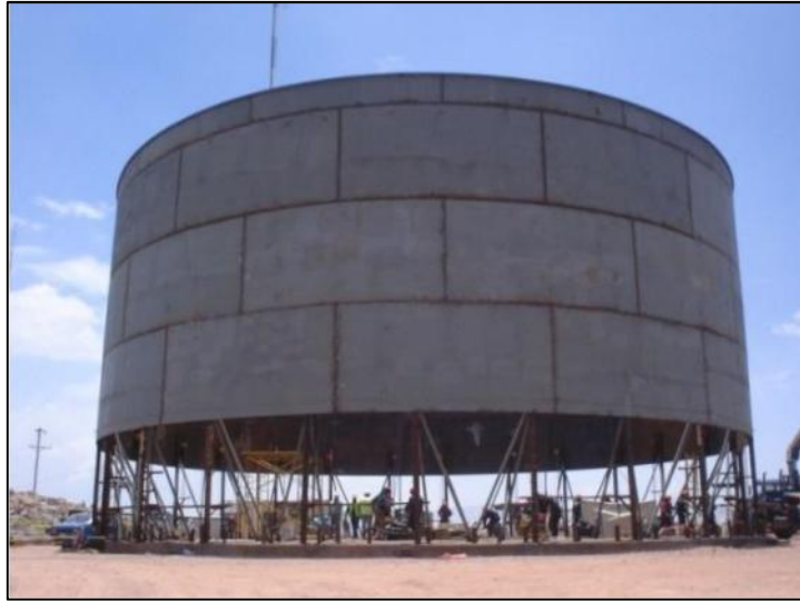
Ilustración 40 - Izaje de Tanque
