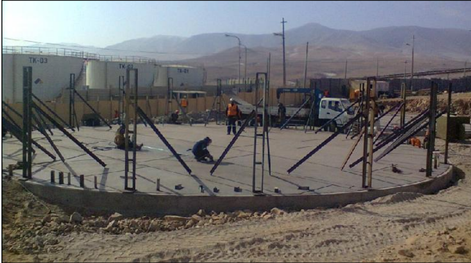
Ilustración 36 - Instalación de columnas de gateo
