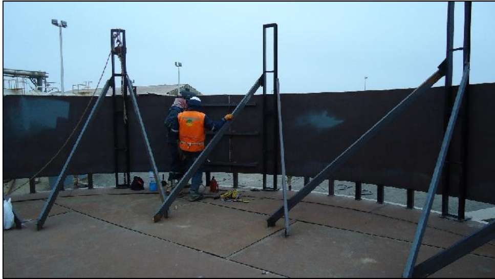
Ilustración 37 - Montaje de Primer Anillo
