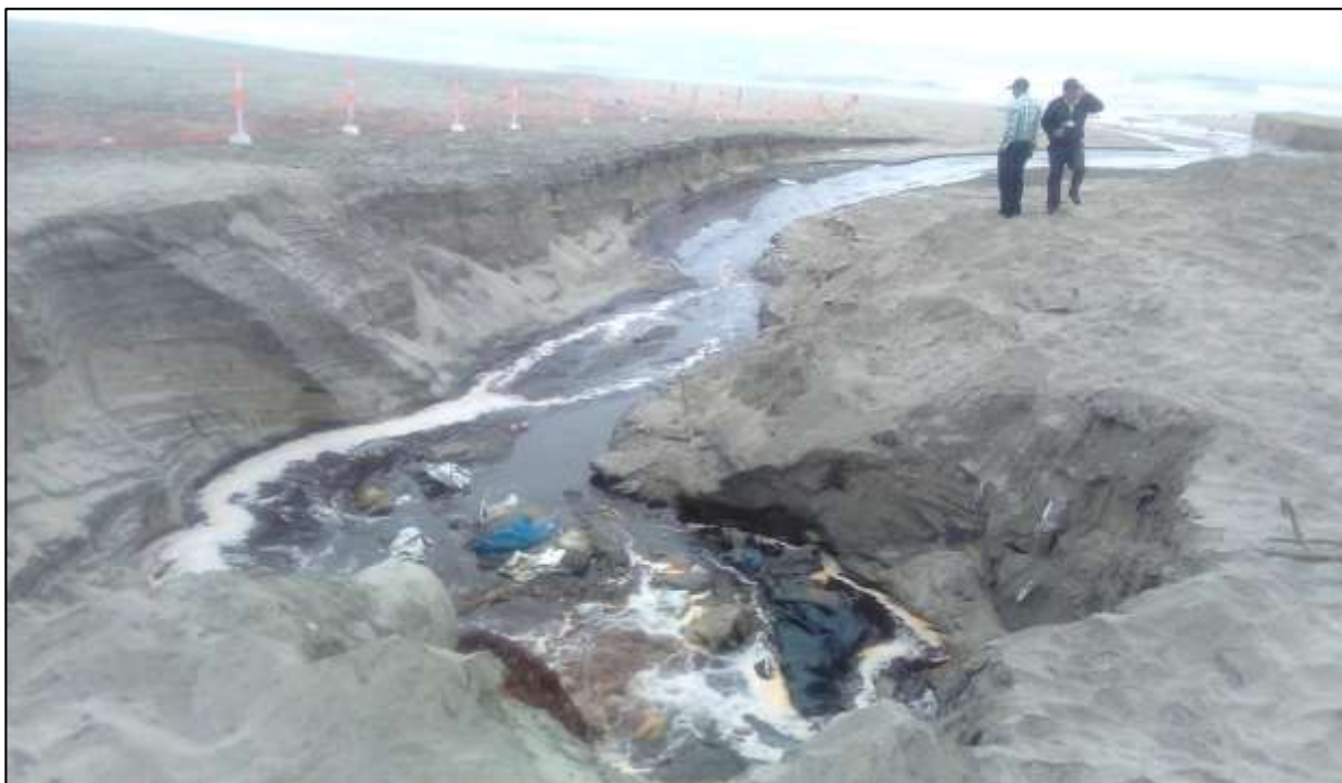
Recorrido de las descargas de aguas servidas provenientes de la tubería de rebose de la empresa SEDAPAL. / PLAYA ARICA KM.40
