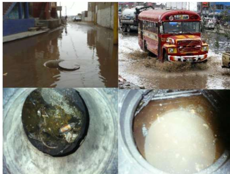
Figura 3. Atoros por el mal uso de colectores.
