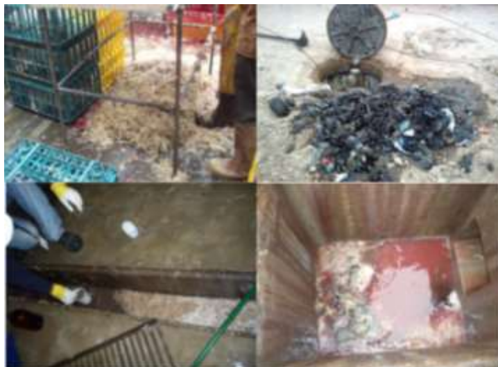
Figura 4. Residuos descargados en la red de alcantarillado.
