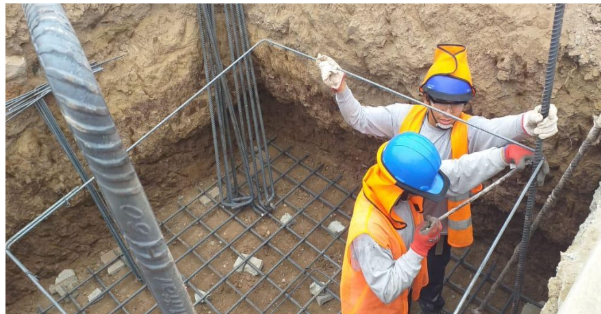
Figura 2. Enmallado de la zapata Fuente: Propia
