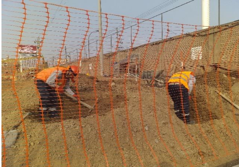
Figura 1. Excavación de la zanja Fuente: Propia
