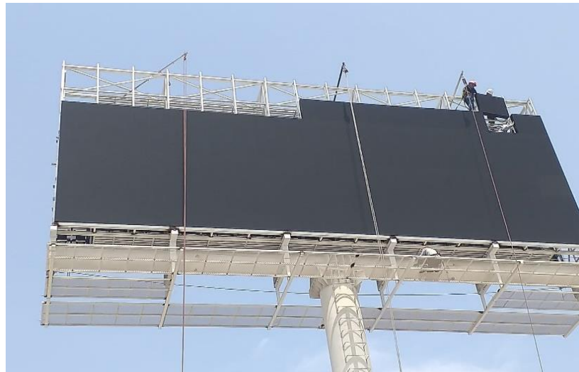
Figura 10. Izaje de los Gabinetes a las Canastillas Fuente: Propia
