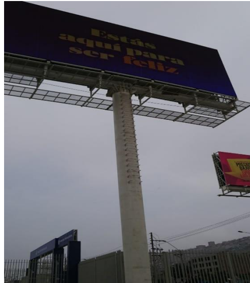
Figura 11. Cableados eléctricos y cableado de datos Fuente: Propia
