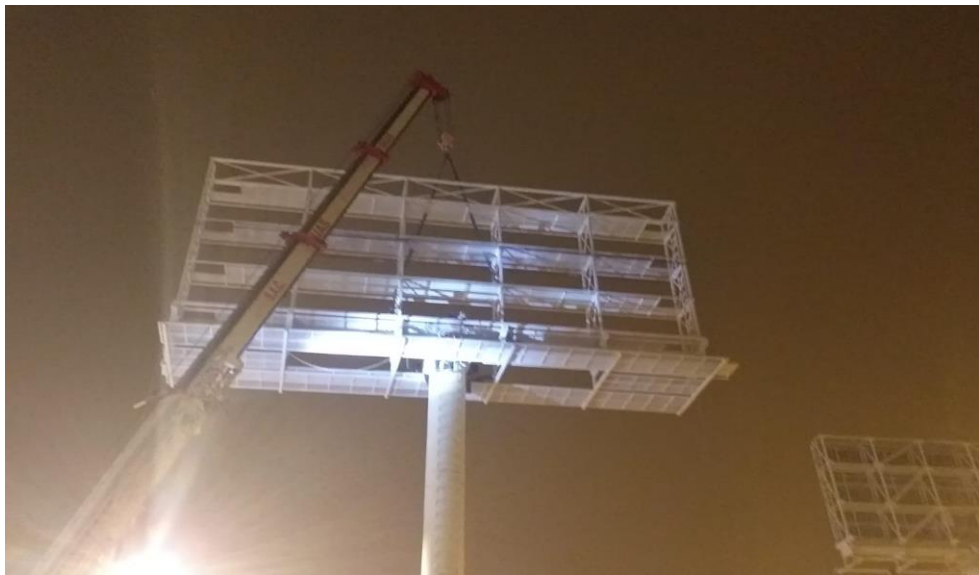
Figura 9. Puesta de la Estructura Portapanel Fuente: Propia
