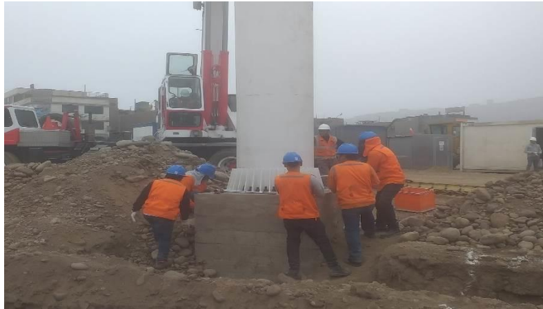
Figura 7. Empernado de la Torre Unipolar al Pedestal Fuente: Propia
