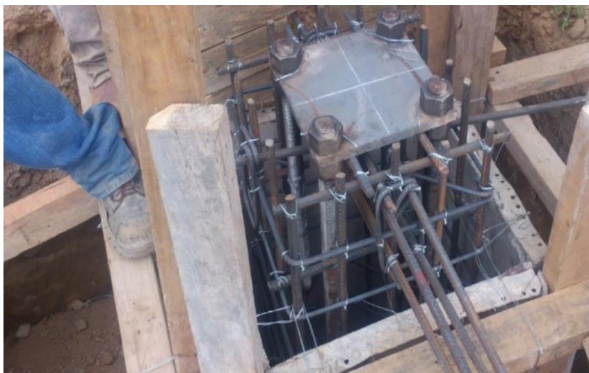
Figura 3. Encofrado de la zapata Fuente: Propia
