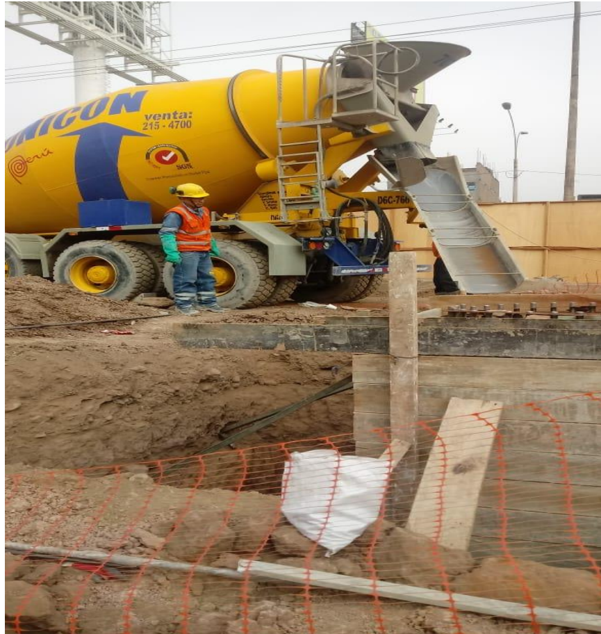
Figura 4. Vaciado de concreto con mixer Fuente: Propia
