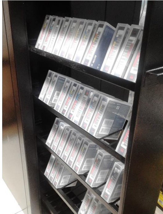
FIGURA 3 34: Cintas grabadas en el rack de almacenamiento FUENTE: Elaboración Propia
