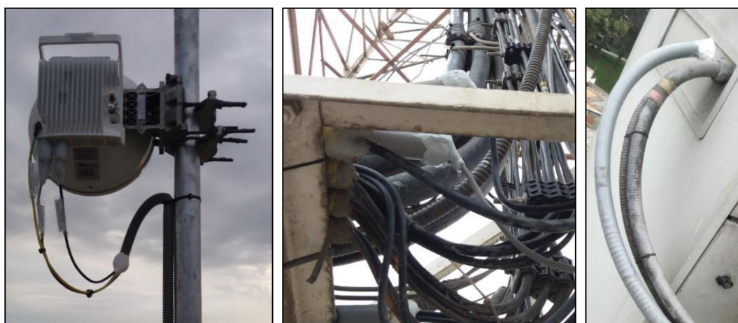
Figura 51: Sellado de tubería Conduit. Fuente: Elaboración propia.
