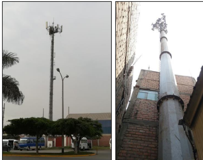
Figura 27: Torre monopolo Fuente: Elaboración propia
