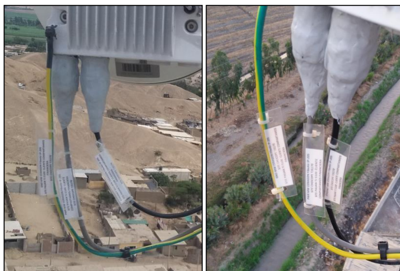
Figura 52: Vulcanizado del conector. Fuente: Elaboración propia.
