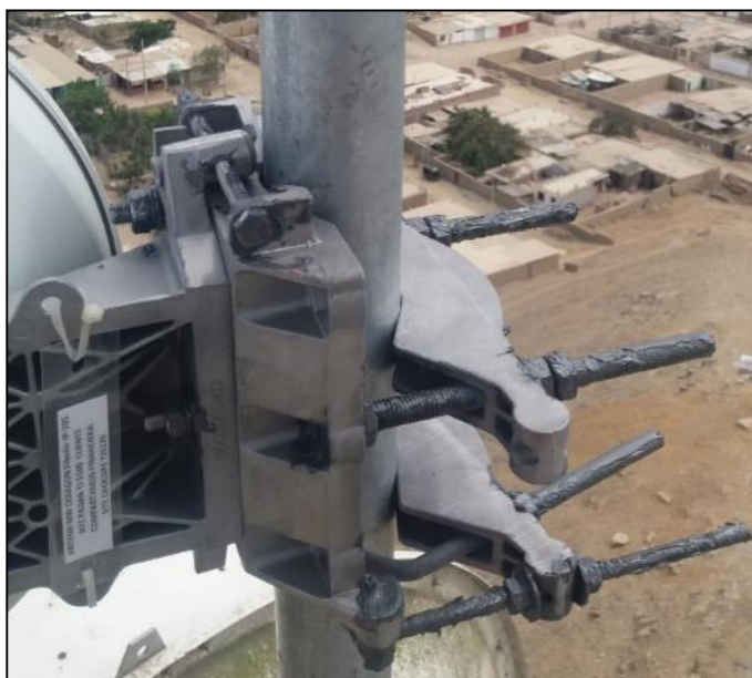
Figura 68: Engrasado de la pernería del soporte. Fuente: Elaboración propia.
