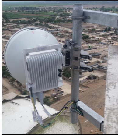
Figura 60: Soporte para torre autosportada, site PAIJAN Fuente: Elaboración propia.
