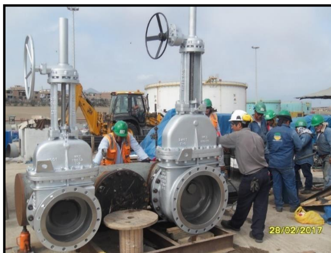
Figura 20: Prueba hidrostática de válvulas compuerta
